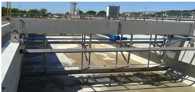
Slika 4.9. Primjer jedne linije taložnika [13]
