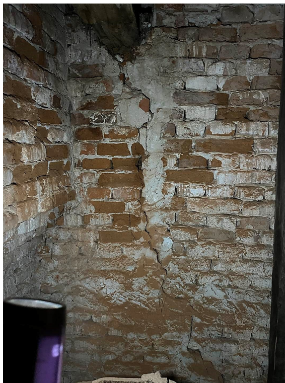
Slika 6.38. Vertikalna pukotina uz južni zvonik crkve, K6
