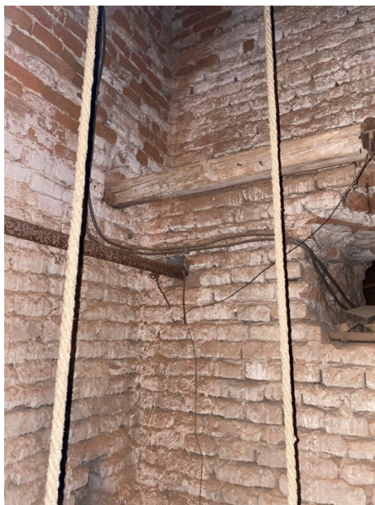
Slika 6.44. Vanjski pogled na zvonik te unutrašnjost zvonika sa starim zategama
