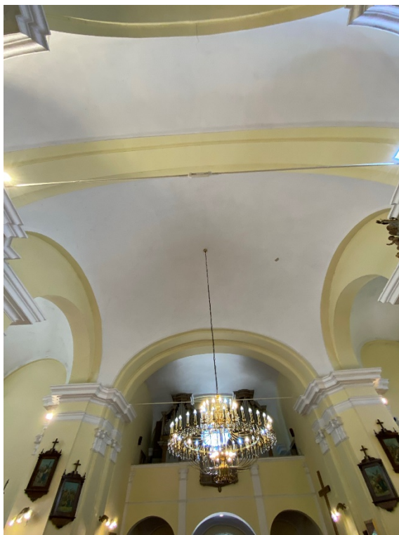
Slika 6.17.Glavni svod crkve te pukotina na trijumfalnom luku svetišta O10
