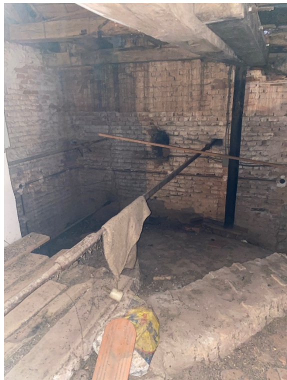
Slika 6.41.K3, prikaz spoja zatege zvonika (na klin)
