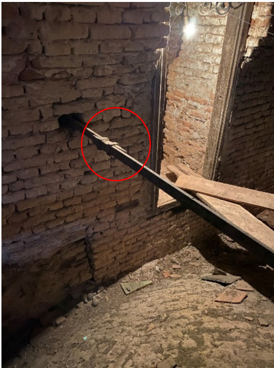
Slika 6.41.K3, prikaz spoja zatege zvonika (na klin)
