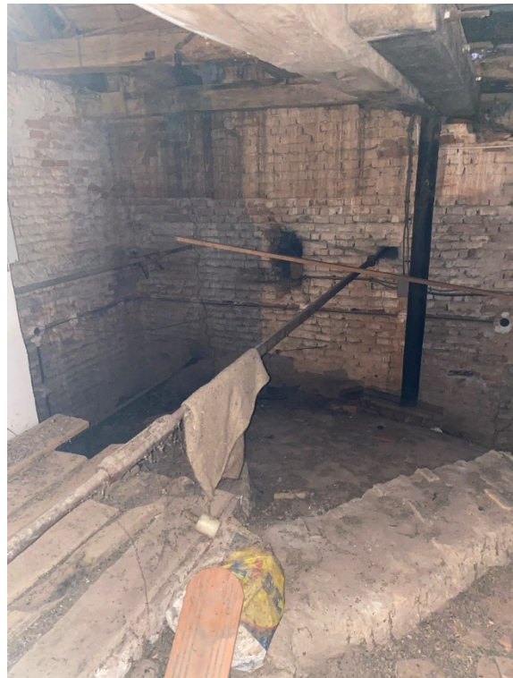
Slika 6.41.K3, prikaz spoja zatege zvonika (na klin)
