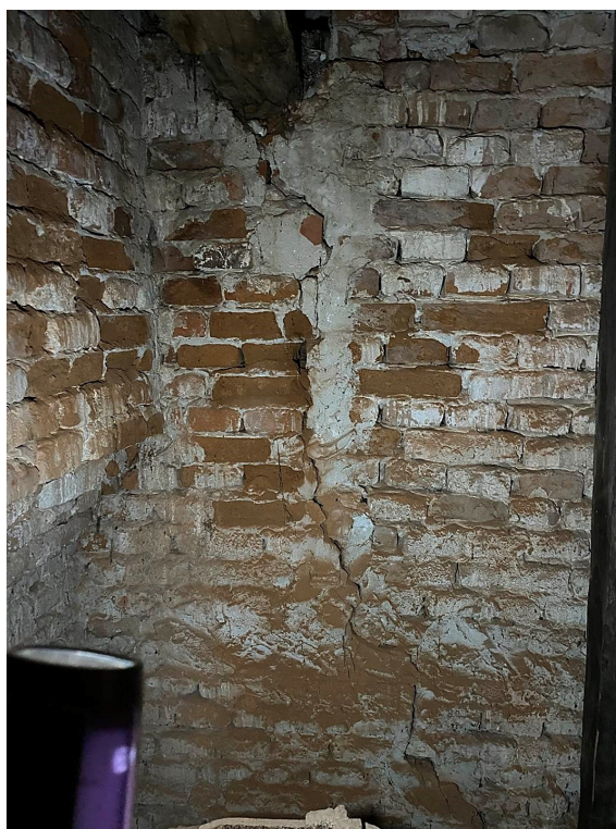
Slika 9.1. Vertikalna pukotina uz južni zvonik crkve, K6
