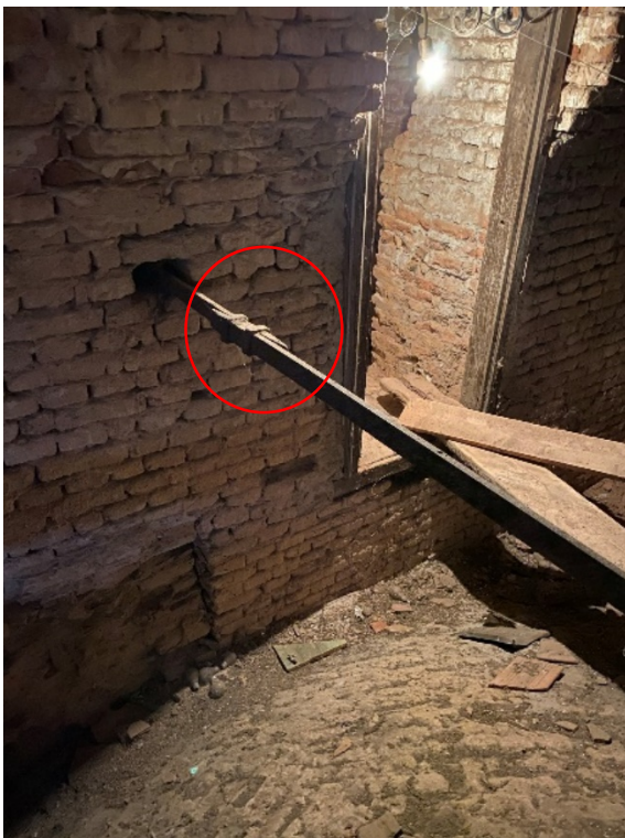
Slika 6.41.K3, prikaz spoja zatege zvonika (na klin)
