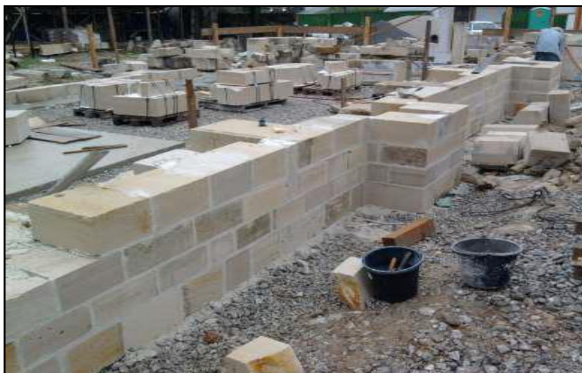
Slika 48. Pogled na zidanje sjevernog zida
