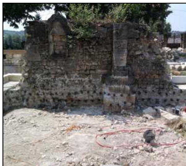
Slika 44. Podgled na injektirani temelj
