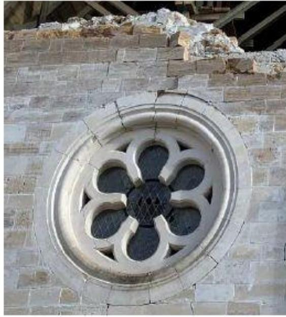
Slika 111. Oštećenje pročeljne rozete
