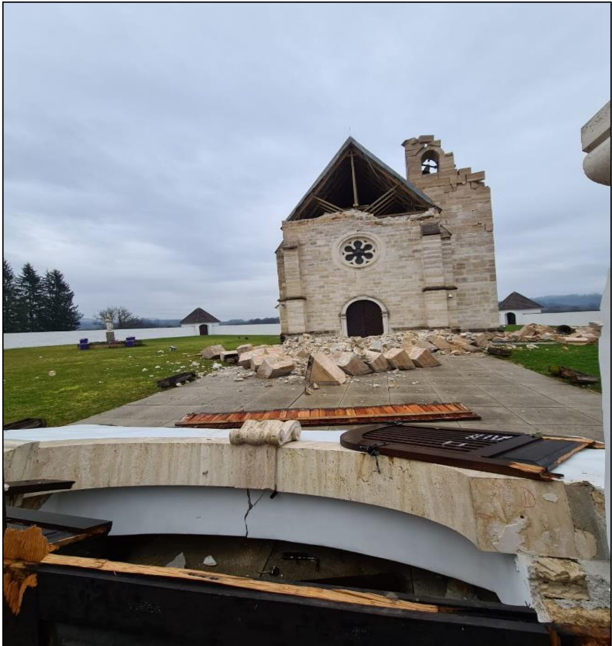
Slika 108. Razrušena crkva nakon potresa
