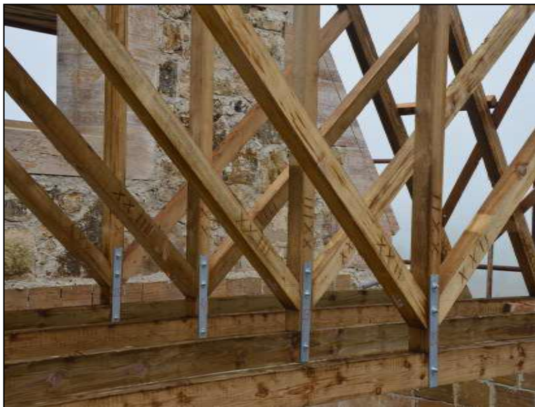
Slika 83. Izvedeni detalj krovišta "D"
