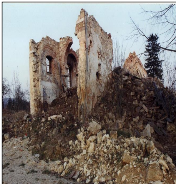
Slika 8. Pogled na zapadno pročelje crkve
