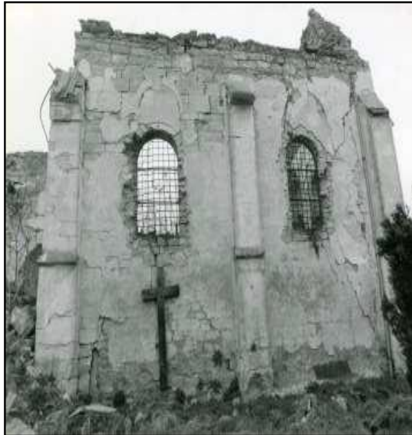
Slika 9. Pogled na južno pročelje crkve
