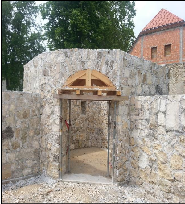
Slika 104. Oplata kamenog nadvoja
