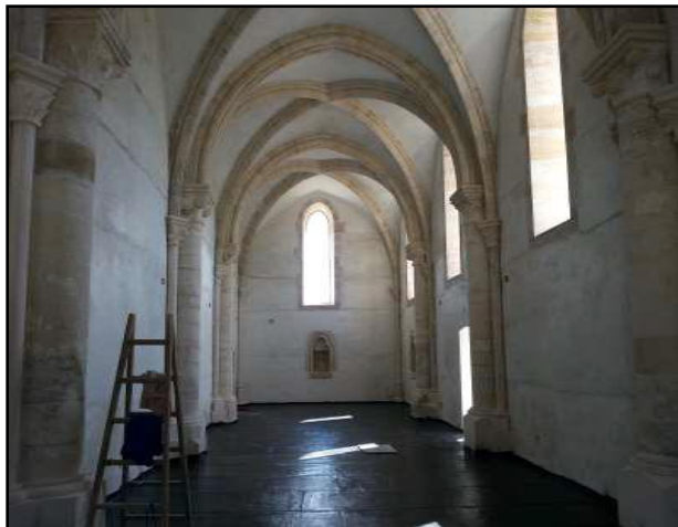
Slika 84. Izvedena hidroizolacija podne ploče (1)
