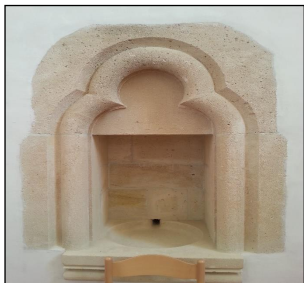
Slika 92. Restauriran sakrarij na južnom zidu
