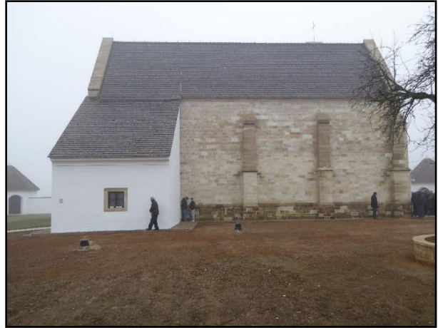
Slika 118. Pogled na južno pročelje
