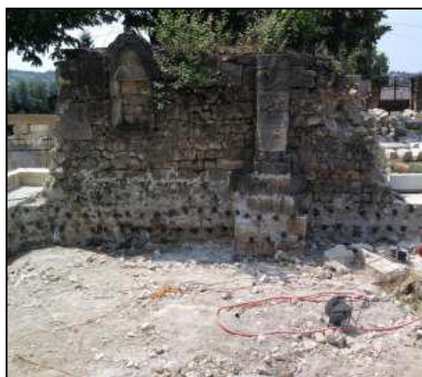
Slika 44. Podgled na injektirani temelj
