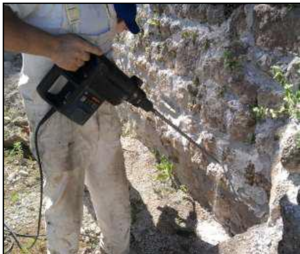
Slika 41. Bušenje temelja
