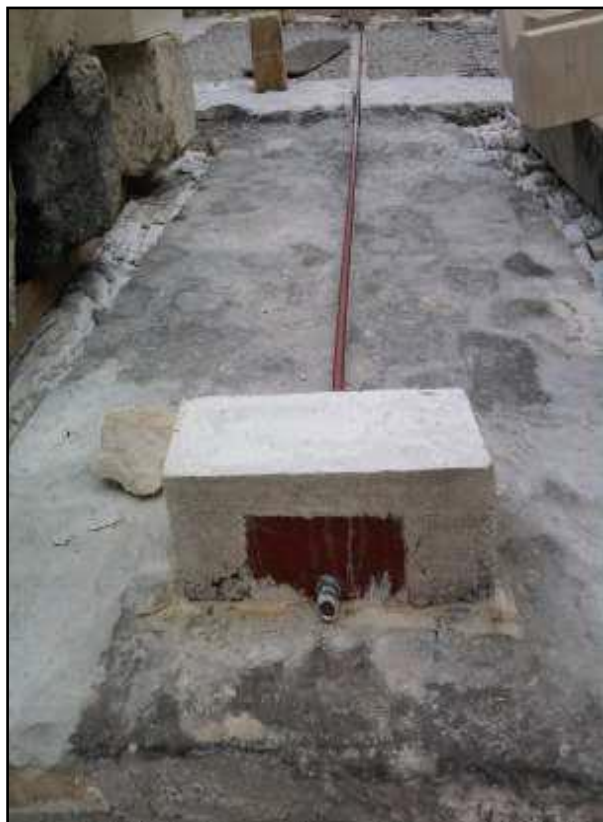
Slika 46. Zatege na temeljnoj ploči
