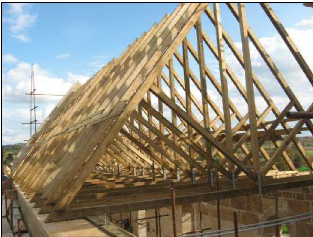
Slika 79.. Izvedeni detalj krovišta "B"
