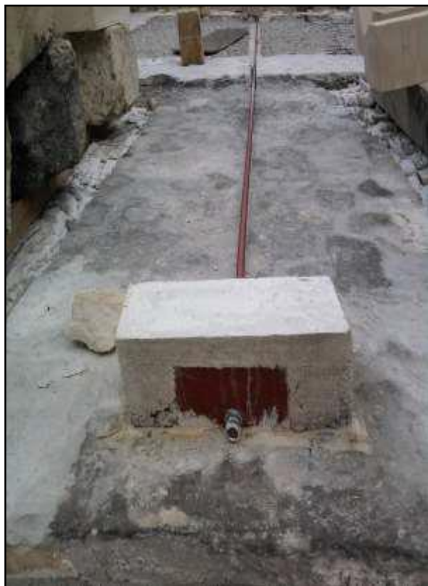
Slika 46. Zatege na temeljnoj ploči
