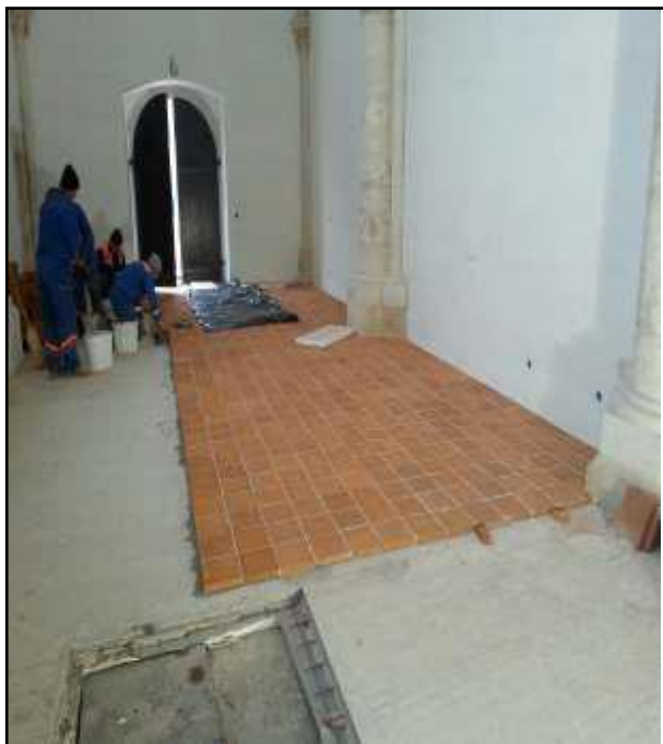
Slika 88. Popločenje poda tavelama
