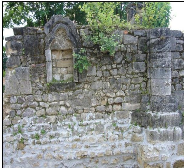
Slika 90. Sakrarij na južnom zidu
