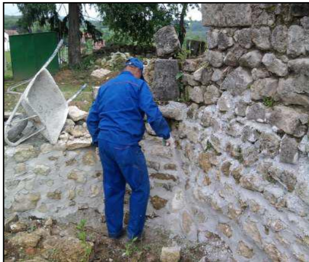
Slika 39. Špricanje temelja mortom
