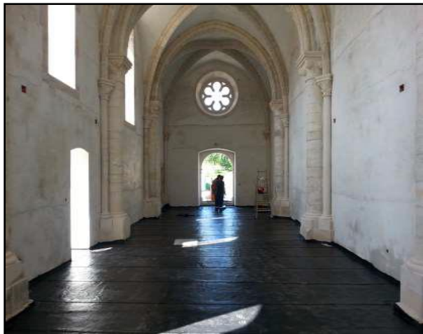
Slika 85. Izvedena hidroizolacija podne ploče (2)
