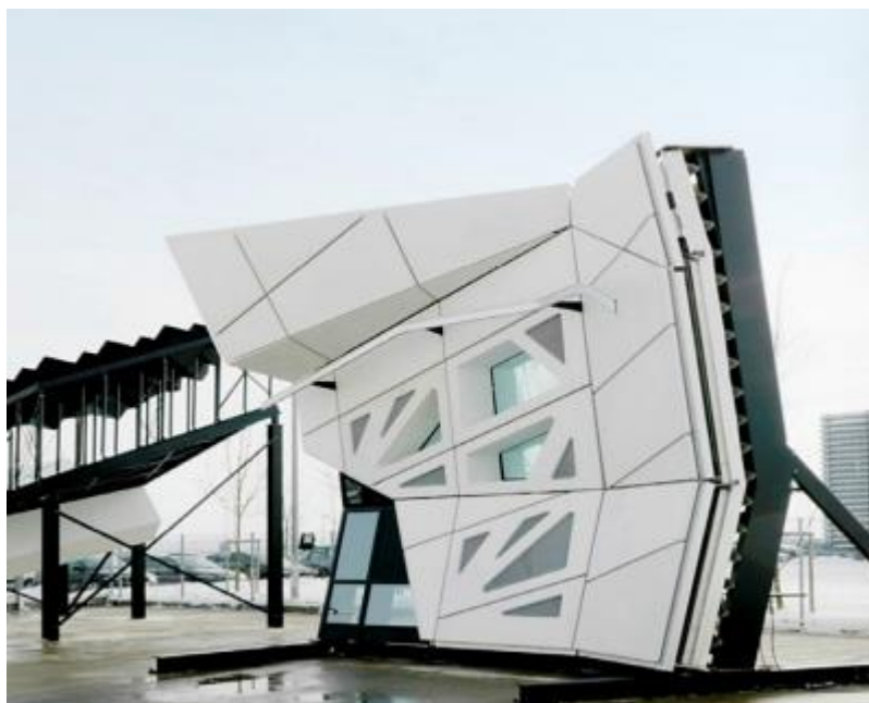
Slika 32. 3D betonski element fasade [40]
