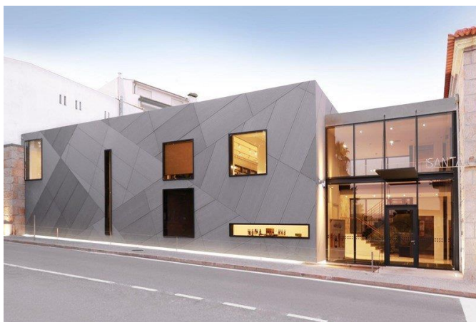
Slika 29. Vlaknocementna ploča kao fasadna obloga [39]
