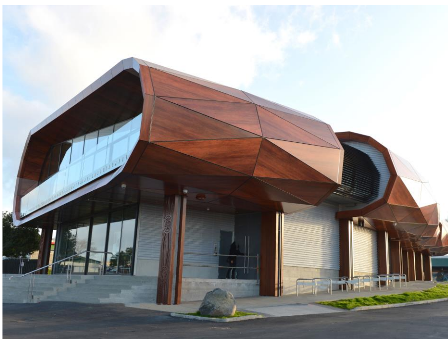
Slika 26. Kompozitni panel kao fasadna obloga [31]
