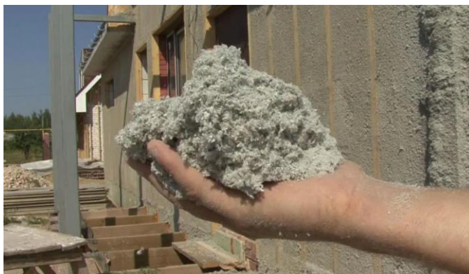
Slika 5. Izolacija celuloznom vunom [9]
