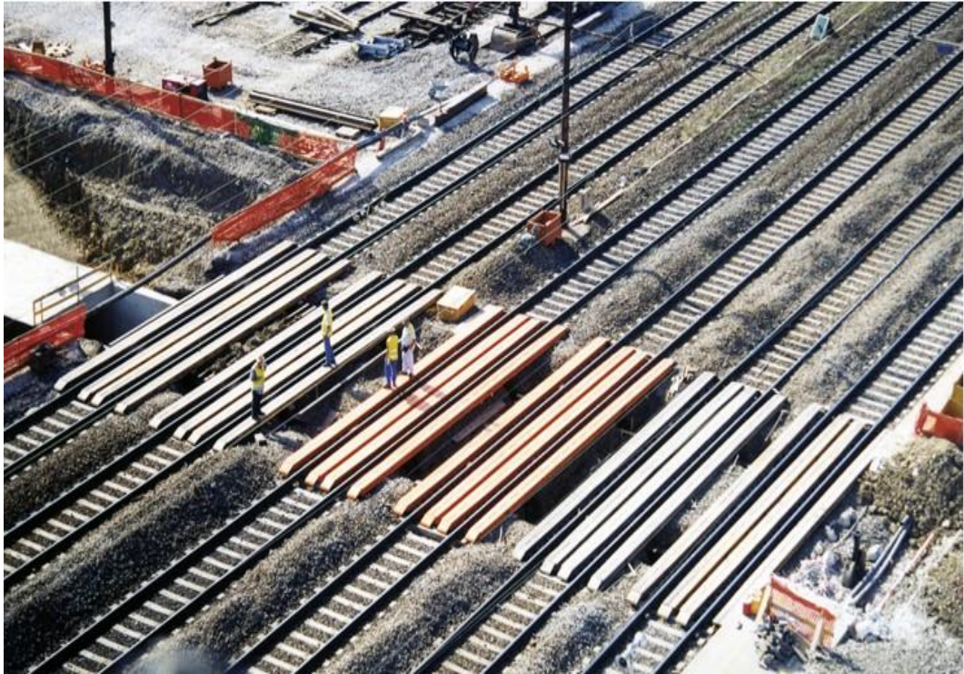
Slika 5.13 Tipičan primjer izgradnje pješačkog pothodnika [2]
