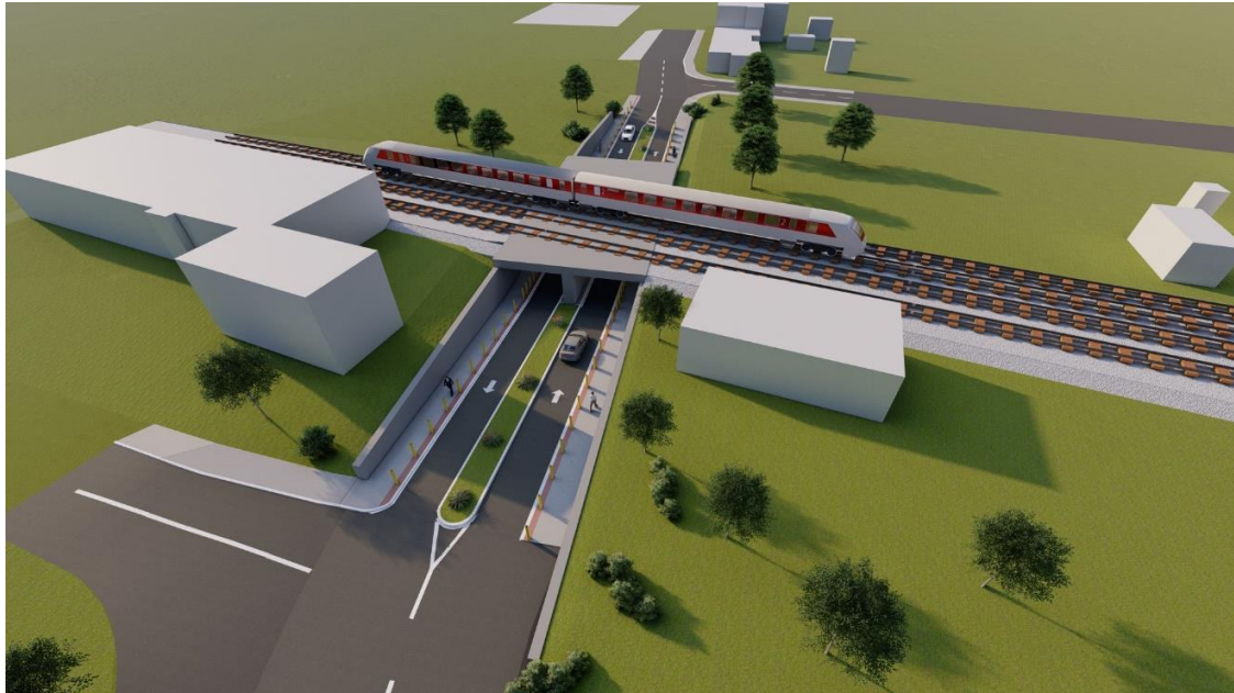
Slika 4.23 3D vizualizacija koncepta prenamjene postojećeg pothodnika u podvožnjak i pothodnik
