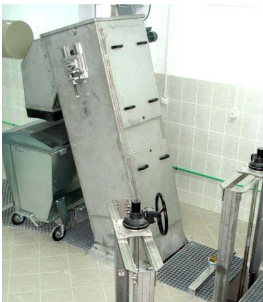
Slika 4.2. Primjer automatske grube lančane rešetke [19]
