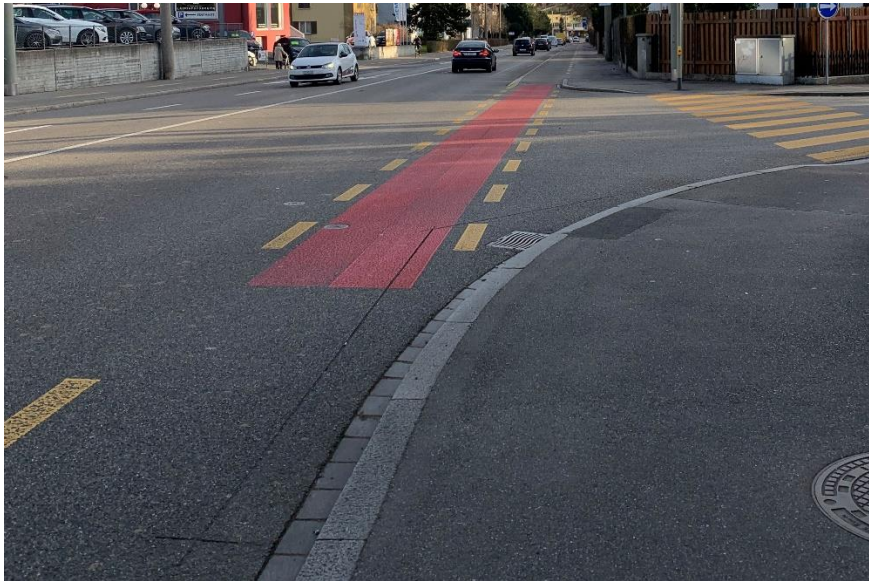
Slika (7.1.1.3.) Biciklistički trak unutar raskrižja
