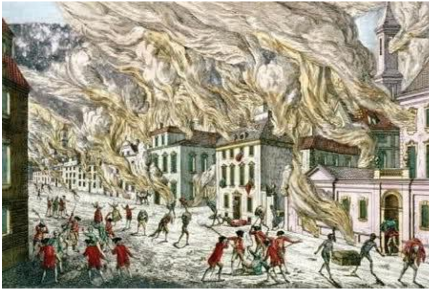
Slika 4.4.1. Požar u Varaždinu (5)
