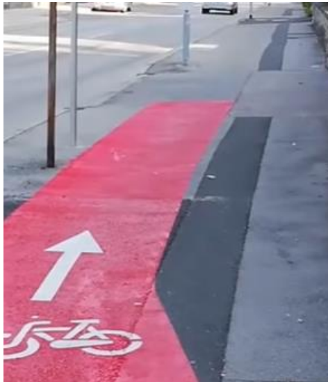
Slika 3.3.8. Prekid biciklističkog traka (3)
