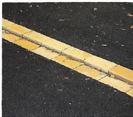
b) postavljanjem betonskog elementa
