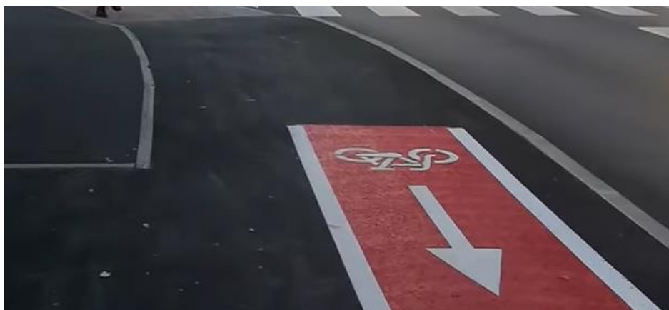
Slika 3.3.2. Iscrtan biciklistički trak (3)
