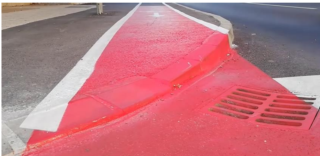
Slika 3.3.5. Uključivanje biciklističkog traka na kolnik (3)
