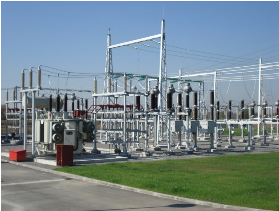
Slika 2.1 Rasklopno postrojenje [3]
