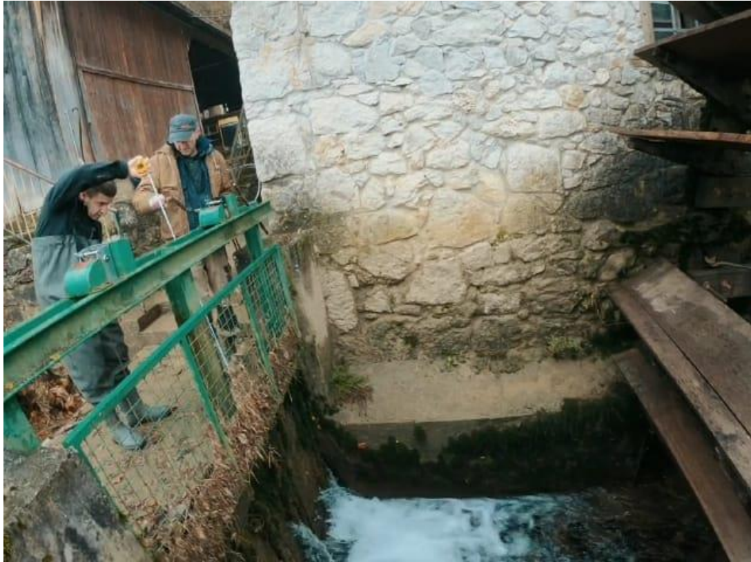
Slika 34. Određivanje visine zapornice i puštanje vode prema vodnom kolu [3]
