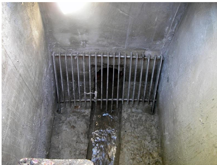
Slika 7: Gruba rešetka u ulaznom šahtu [11]
