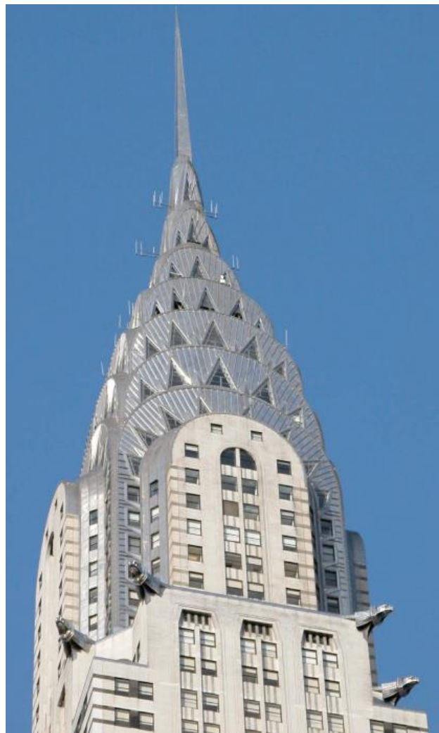
Slika 5.1 Krov Chrysler zgrade izrađen od nehrđajućeg čelika [32]
