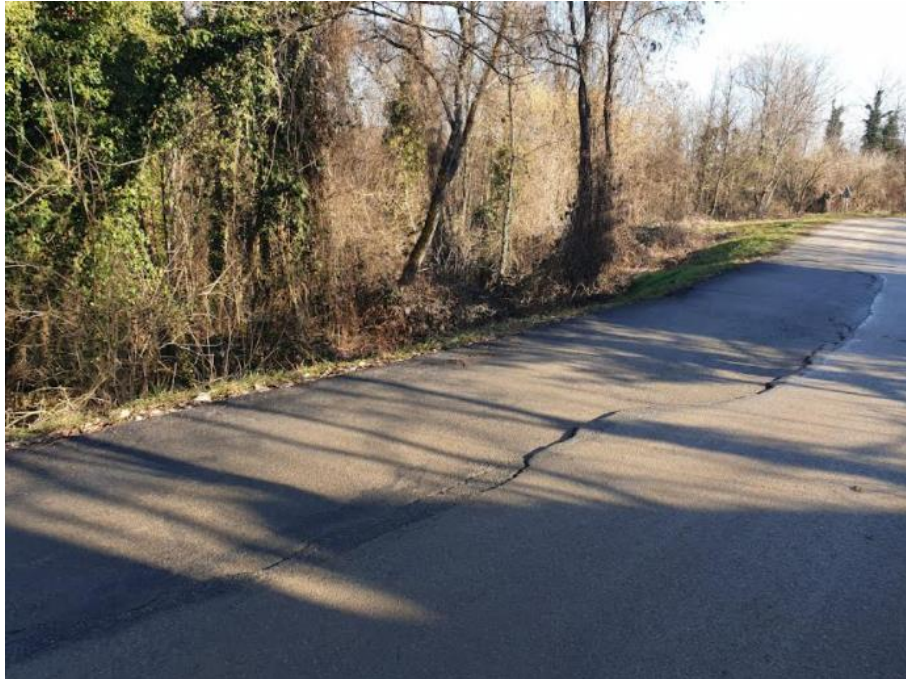
Slika 2.8.: Polagano puzanje mase koje uzrokuje klizanje [3]
