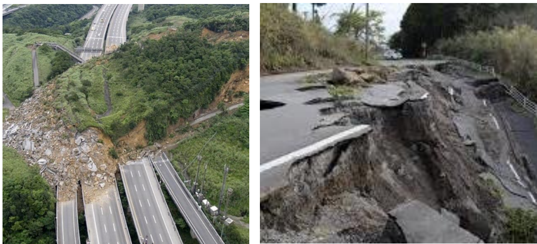
Slika 1.1.: Primjeri nastanka klizišta za vrijeme potresa u Japanu [3]
