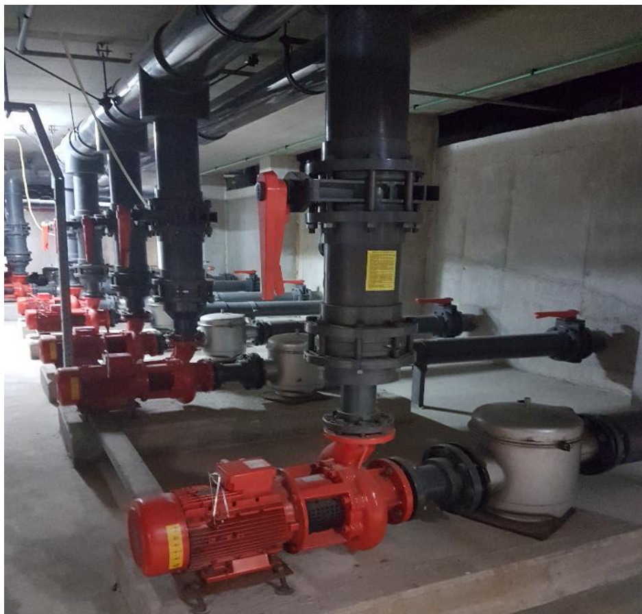
Slika 3.2 Filterske crpke s pred filterom (vlastiti izvor)
