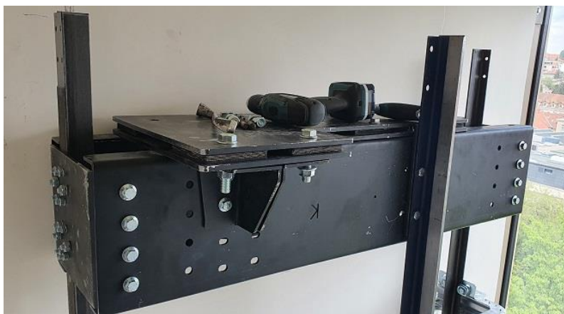
Slika 13. Nosač pogona dizala [3]
