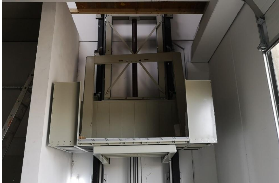
Slika 4. Teretna platforma tijekom montaže (skladište u Macincu)
