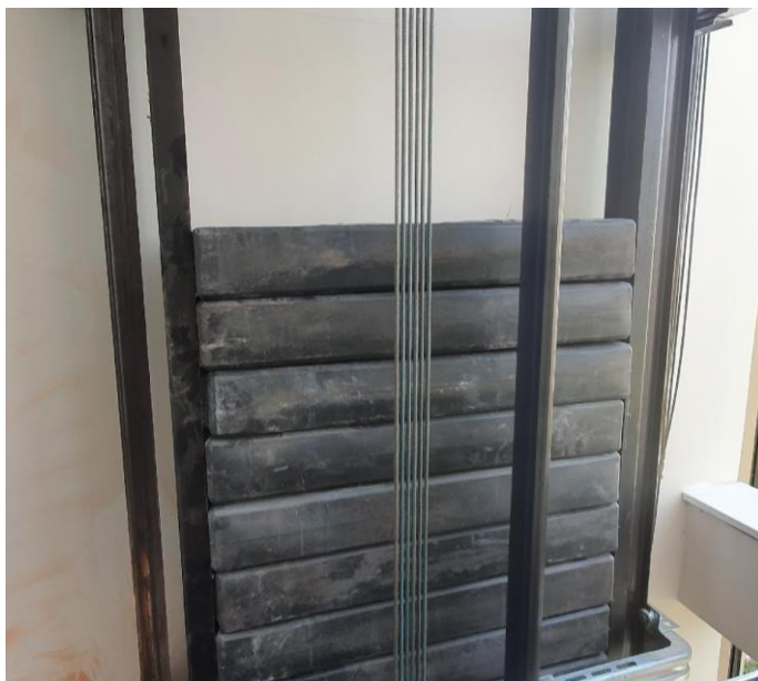
Slika 22. Elementi protuutega [3]
