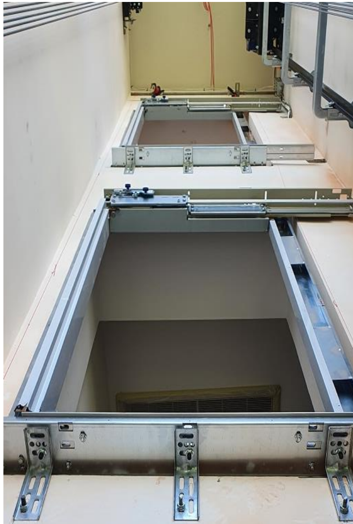
Slika 23. Vrata voznoga okna [3]
