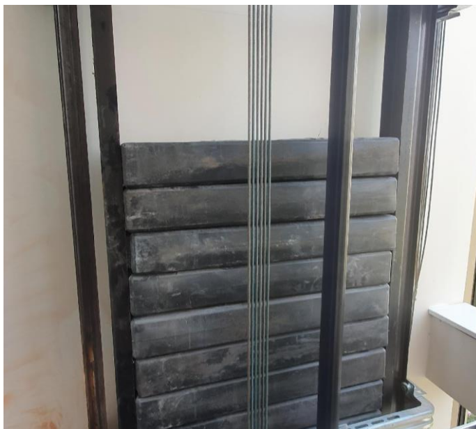
Slika 22. Elementi protuutega [3]
