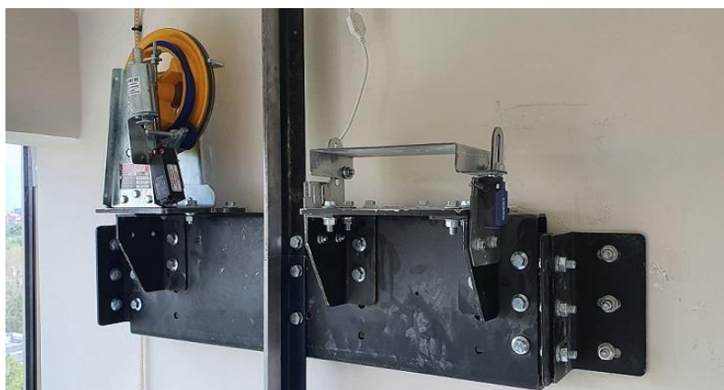
Slika 14. Nosač čelične užadi i regulatora brzine [3]
