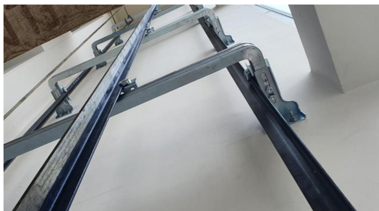
Slika 12. Montirane vodilice [3]
