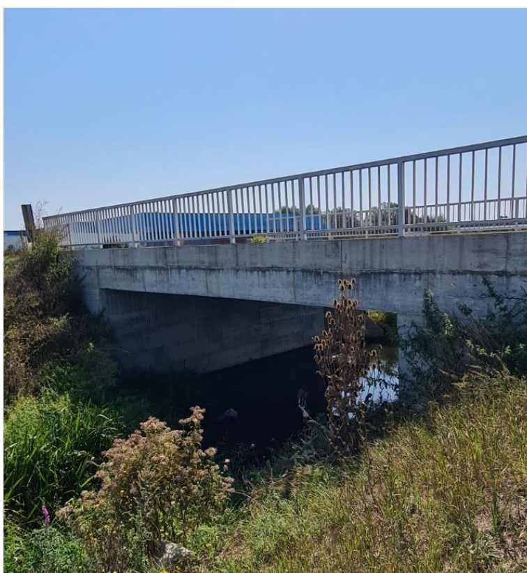
Slika 6.1. Izvedeno stanje – sjeverozapadni pogled na most
