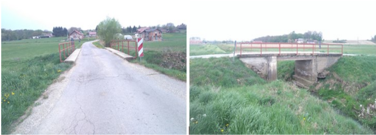
Slika 3.3. Postojeće stanje prometnice
