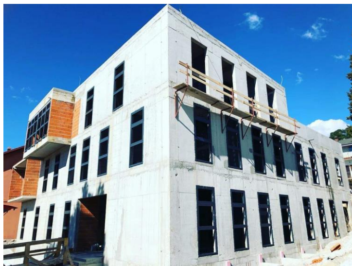
Slika 3.5 Prikaz zidanih dijelova
