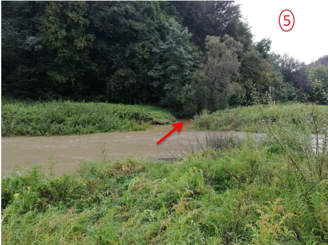
Slika 4.8. Prikaz uljeva potoka Ivanečka Željeznica i Vidovečka Željeznica na lokaciji Željeznica, (18.09.2022.)
