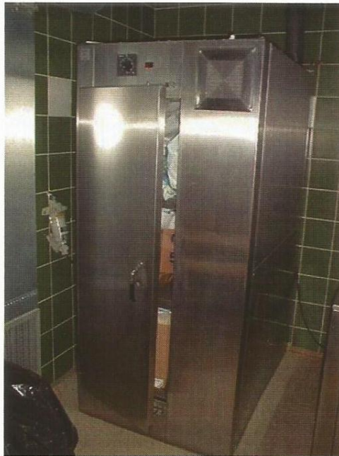
Slika 2.6.5.1. Ormar za prozračivanje etilen-oksida
