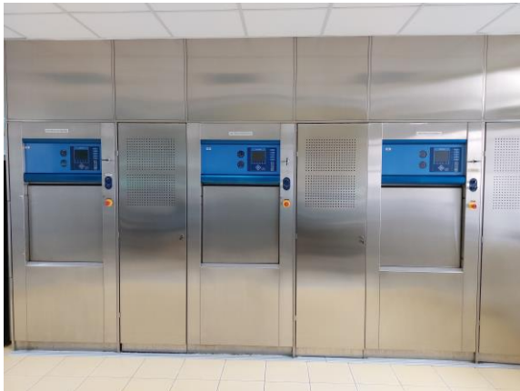
Slika 3.2.1. Autoklavi (Izvor: L. B.)
