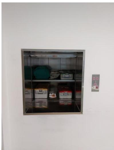
Slika 3.3.4. Dizalo za slanje sterilnih operacijskih kaseti i instrumenata
