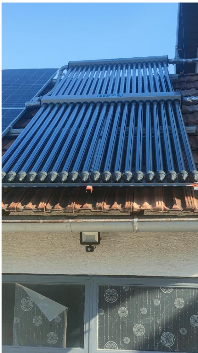
Slika 3.8 Solarme vakumske tube za zagrijavanje vode
