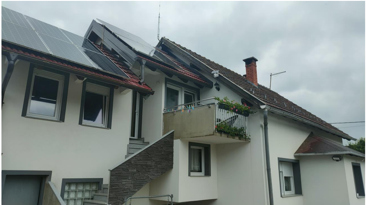
Slika 3.2 slika nakon postavljene termo fasade od 15 cm
