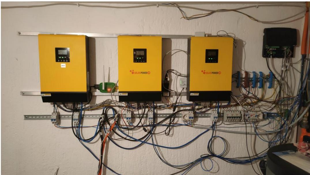
Slika 3.7 Solarni pretvarači u trofaznom sustavu
