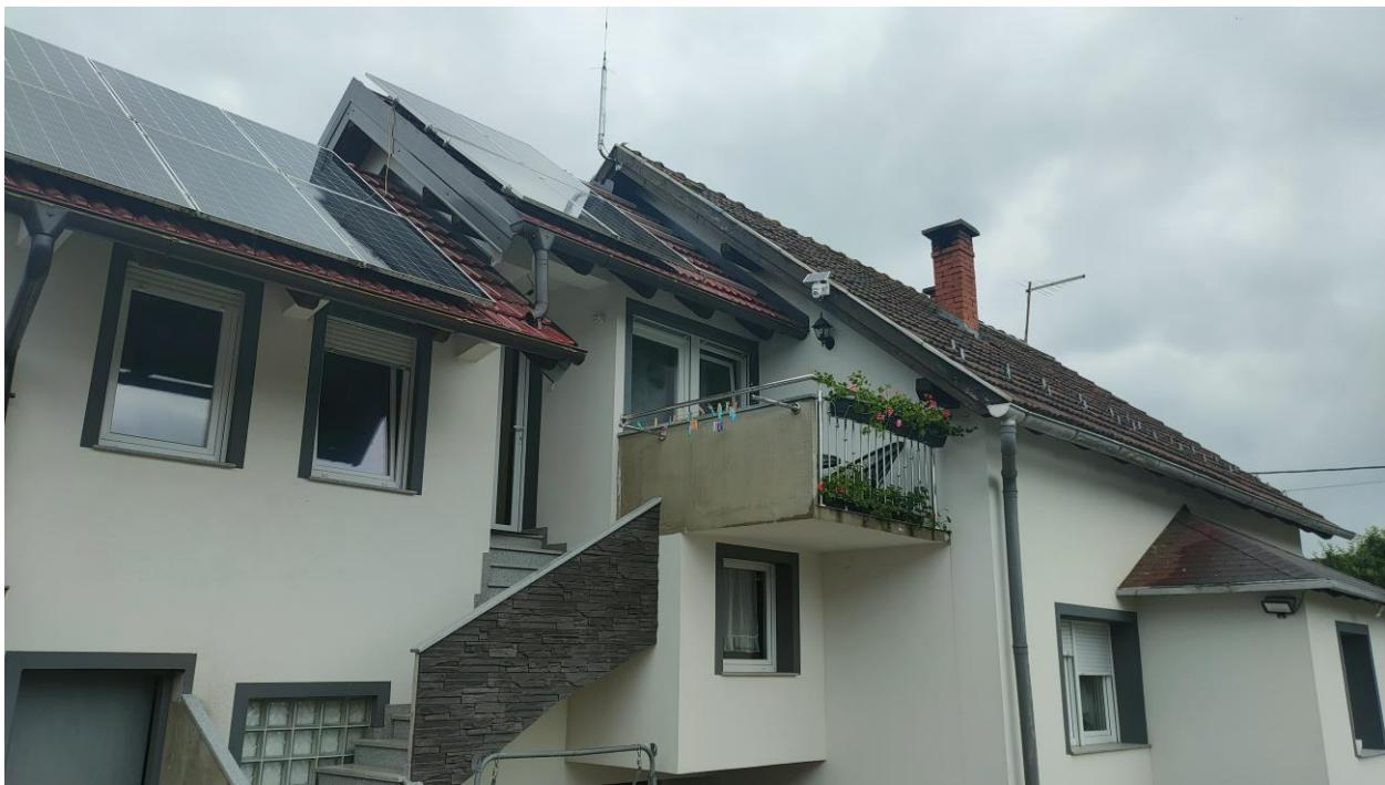
*Slika 3.2 slika nakon postavljenje termo fasade od 15 cm*
