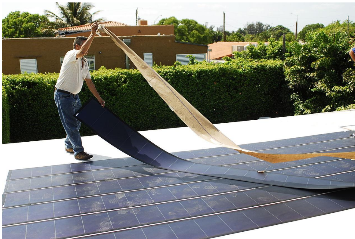
Slika 2.9 Fleksibilnost i praktičnost polimernih ćelija
