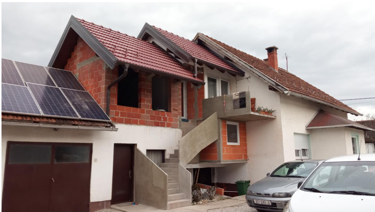
Slika 3.1 Stanje kuće prije postavljanja termo fasade
