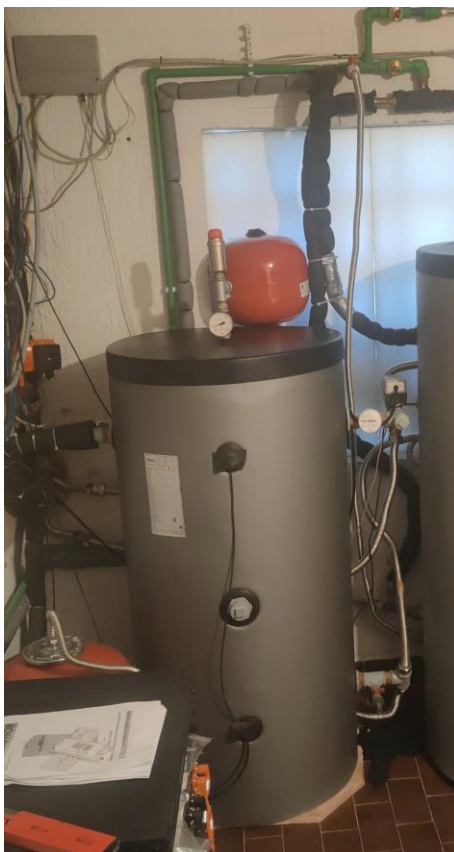
Slika 3.11 akumulacija topline za grijanje - puffer
