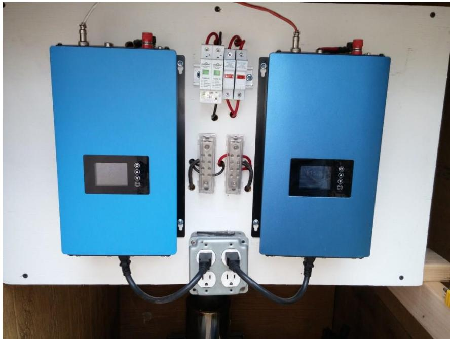
Slika 2.12 Grid tie (mrežni) inverter spojen na mrežu (<https://sunelec.com/zero-export-grid-tie/>)
