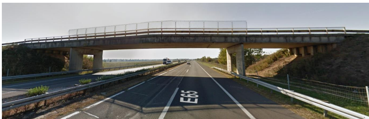
Slika 5. Nadvožnjak s tri otvora
