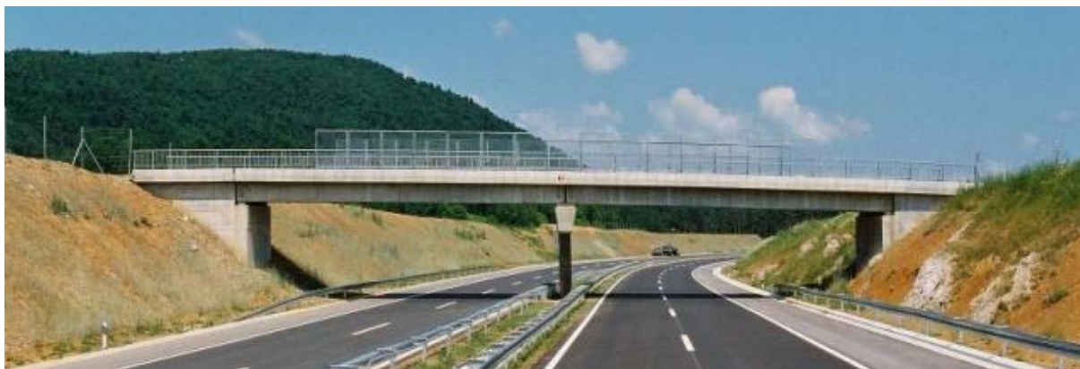
Slika 4. Nadvožnjak sa dva otvora
