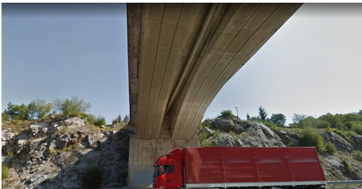
Slika 7. Pogled na svod lučnog nadvožnjaka na dionici Donja Orehovica - Kikovica
