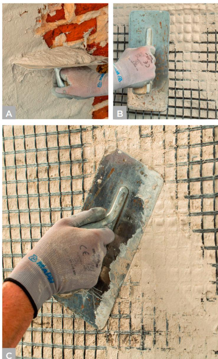
Slika 46. Prikaz postupka ojačanja - FRCM sustav (izvor: brošura Mapei, Protupotresna ojačanja konstrukcija) [16]
