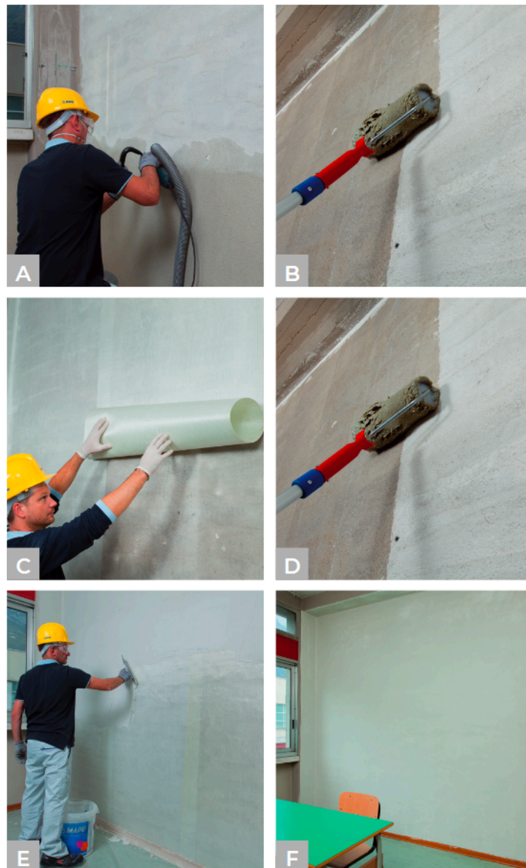
Slika 48. Prikaz postupka ojačanja – MAPEWRAP EQ sustav (izvor: brošura Mapei, Protupotresna ojačanja konstrukcija) [16]
