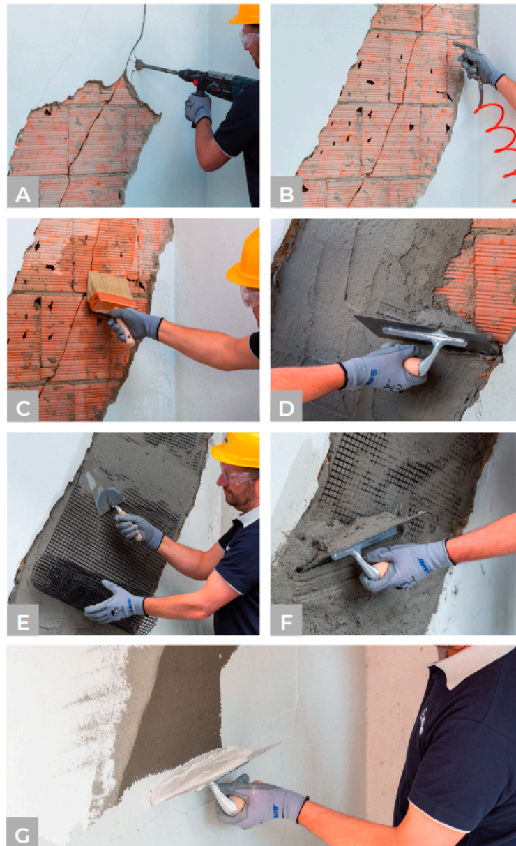
Slika 47. Prikaz postupka ojačanja - FRCM sustav (izvor: brošura Mapei, Protupotresna ojačanja konstrukcija) [16]
