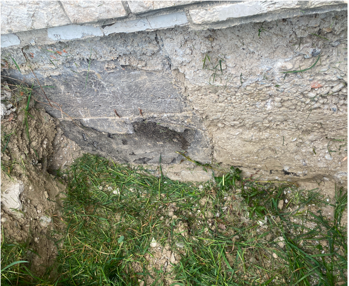
Slika 43. Prikaz otkopanog trakastog temelja na očevidu
