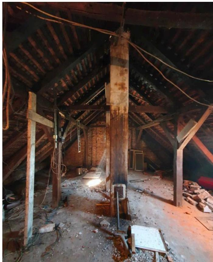
*Slika 19. Krovna konstrukcija i dimnjak u potkroviju predmetne građevine*
