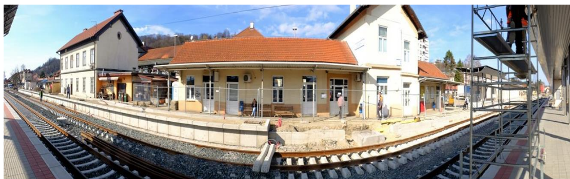
Slika 22. Radovi u kolodvoru Zabok
