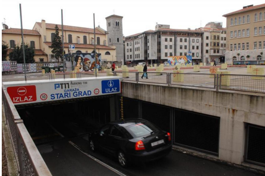
Slika 4.: Podzemna garaža „Stari grad“ u Rijeci
