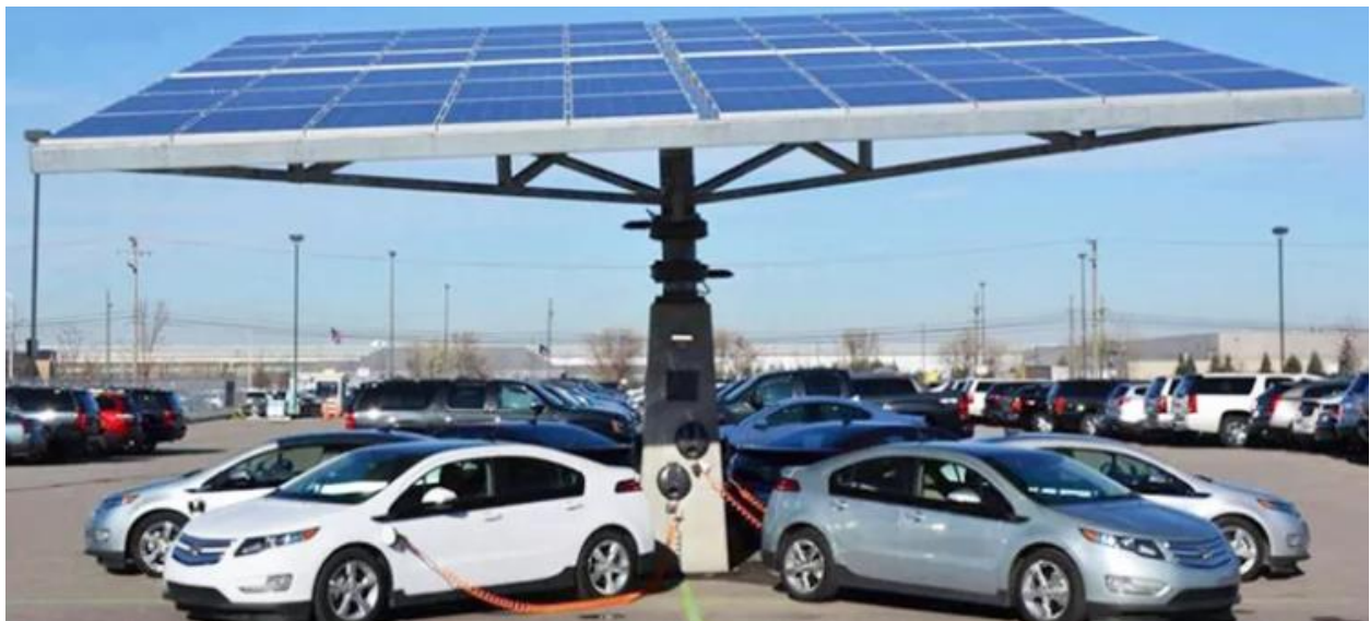
Slika 6. Solarno punjenje na parkiralištu
