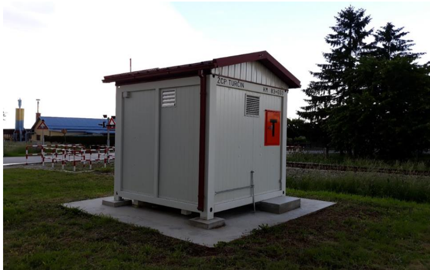
Slika 51. Kućica za smještaj unutrašnjih dijelova uređaja
