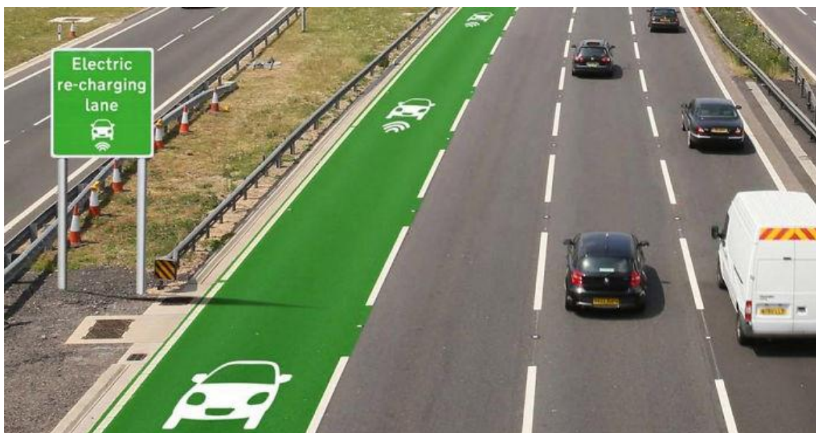
Slika 27. Autocesta s prometnim trakom za bežično punjenje električnih vozila
