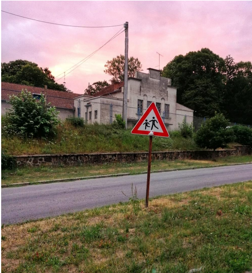
Slika 17. Loše postavljeni prometni znak
