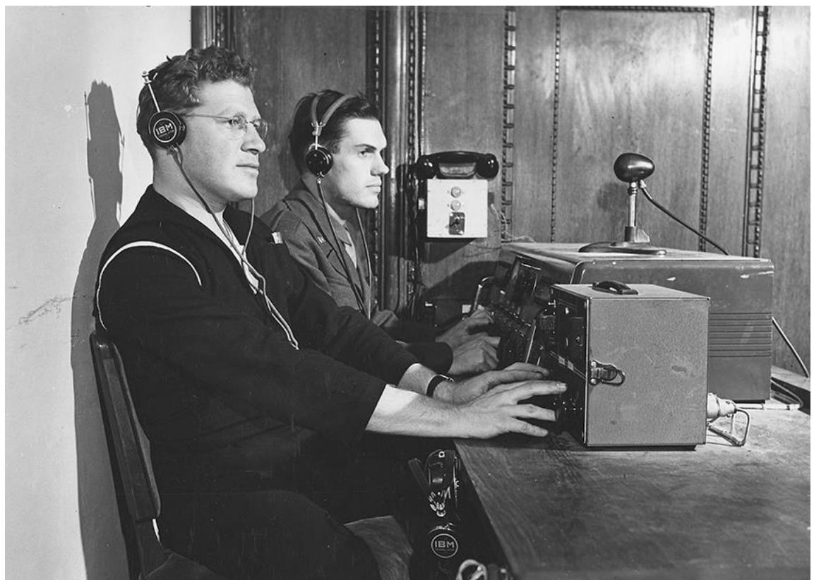
Slika 3. IBM-ova oprema za simultano prevođenje
