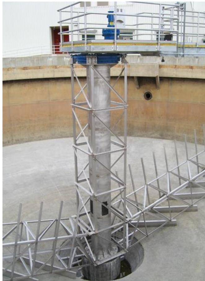
Slika 8: Gravitacijski zgušnjivač mulja [12]
