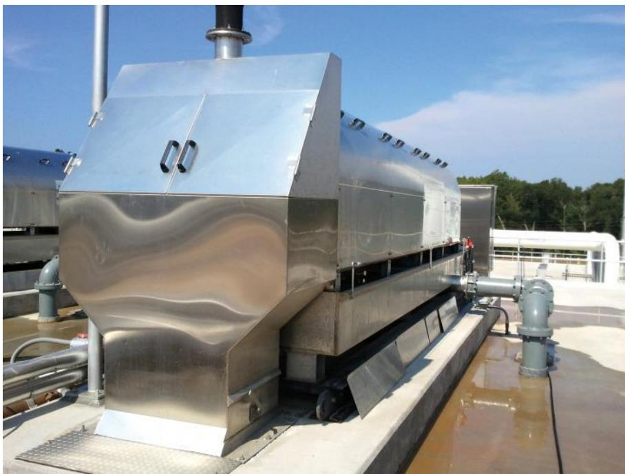
Slika 9: Mehaničko zgušnjavanje mulja pomoću rotacijskog bubenja [13]
