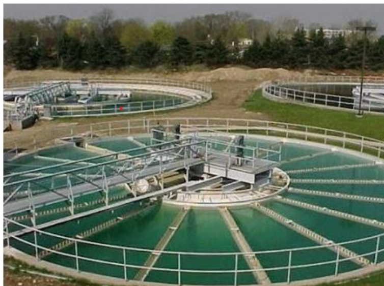
Slika 4: Primjer kružnog taložnika [7]
