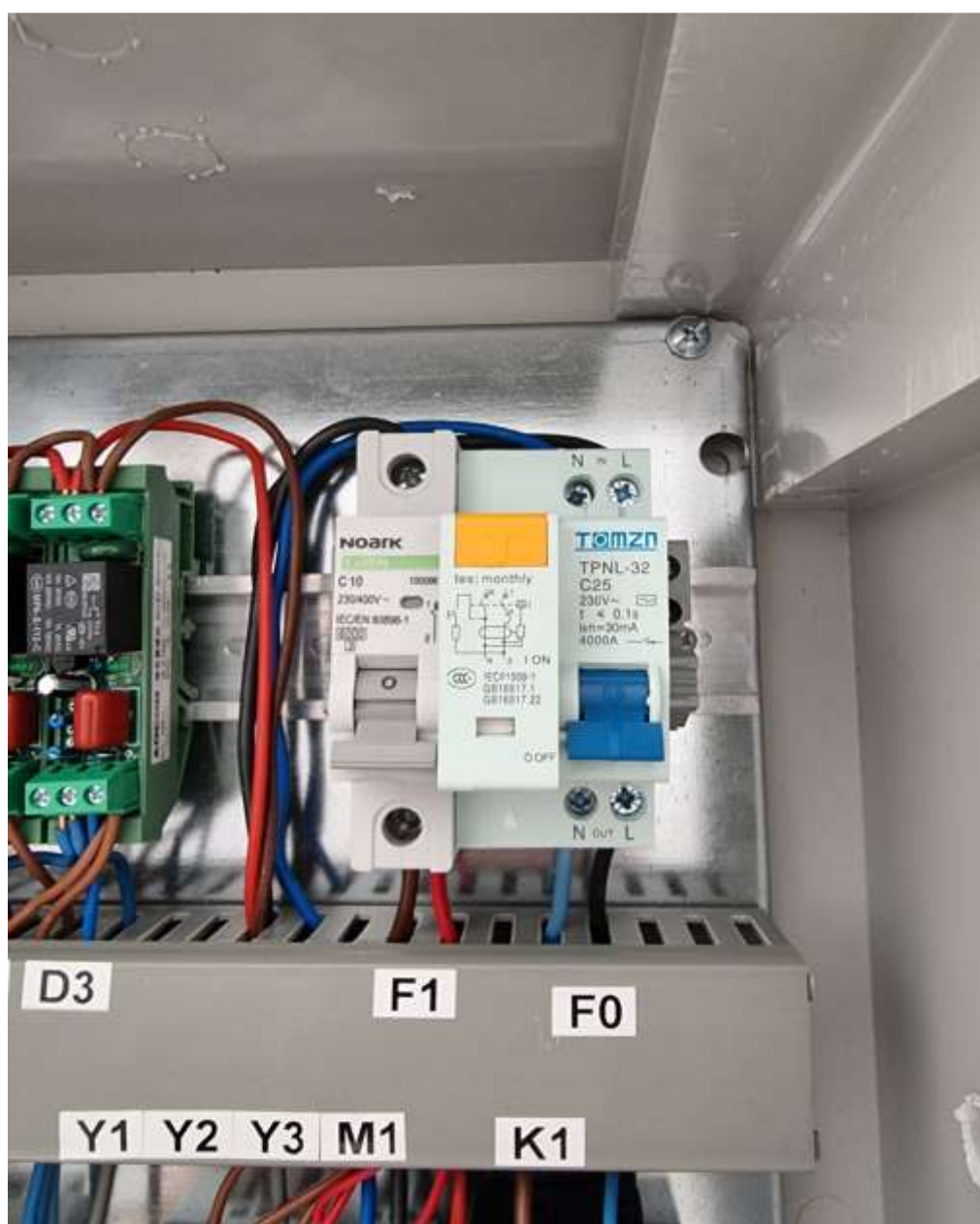
Slika 5.1. Osigurač i fid sklopka
