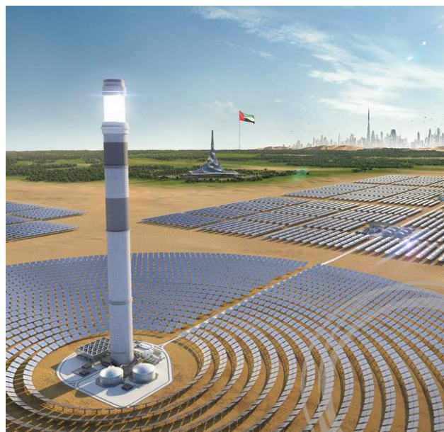
Slika 1.3; Heliostatski toranj solarne energije [10]
