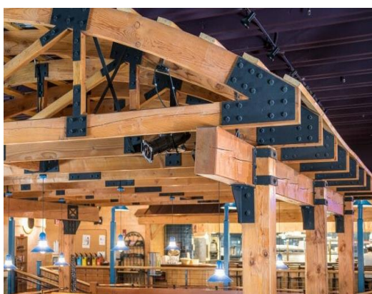
Slika 71. Spojne ploče [16]
