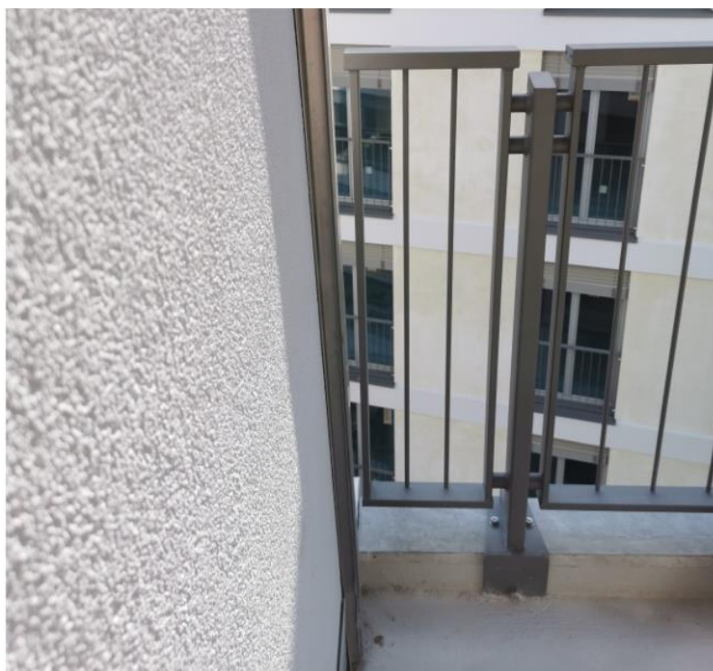
Slika 57: Balkonska ograda nakon montaže [11]
