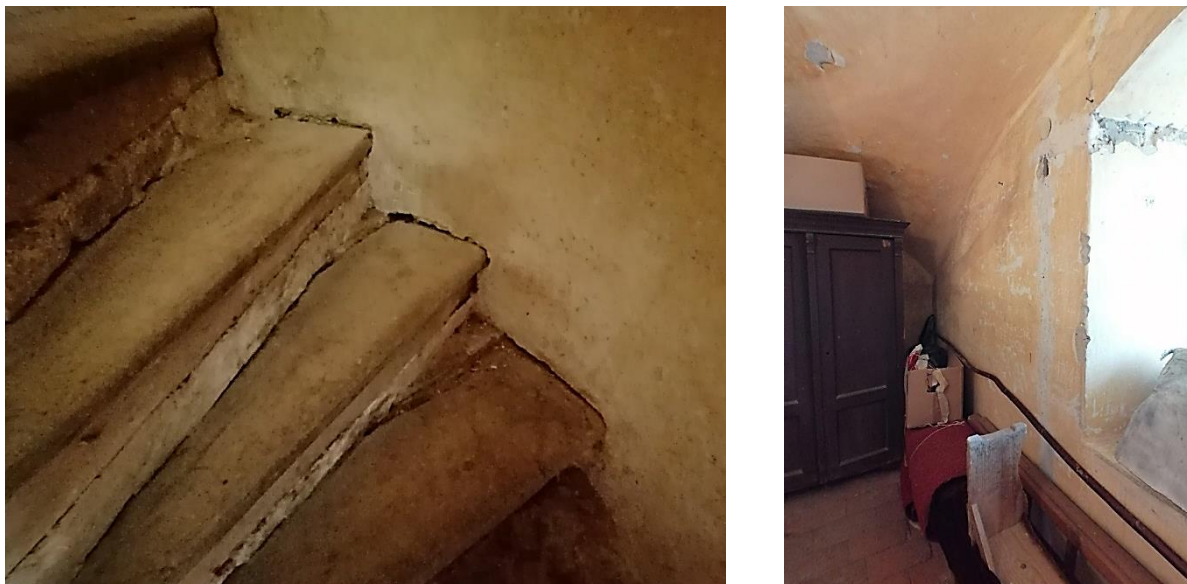
Slika 35. Stubište na kat pjevalište te samo pjevalište (kor)
