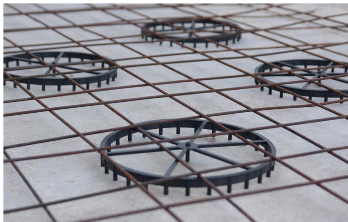
Slika 4.2.2. upotreba odstožnika armaturne mreže [5]
