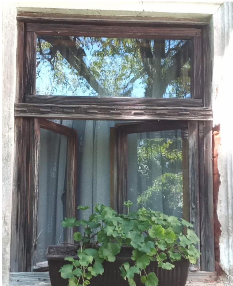
Slika 5.35. Prikaz istrunulih drvenih prozora
