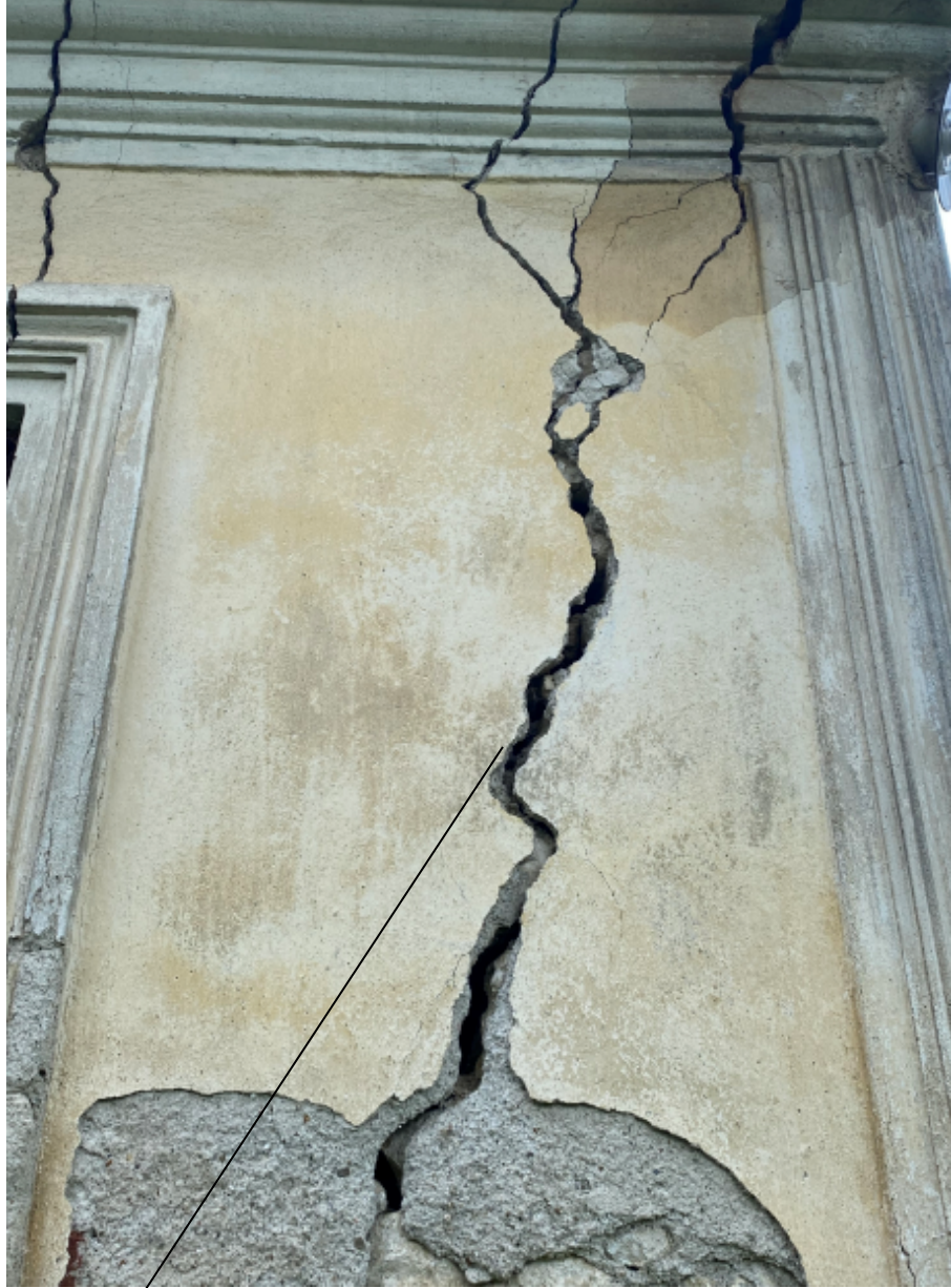
Slika 5.20. Detaljni prikaz slike 5.18., južno pročelje
