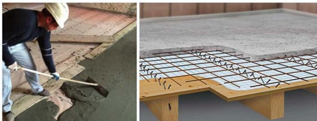
Slika 7.6. Prikaz armiranobetonske ploče
