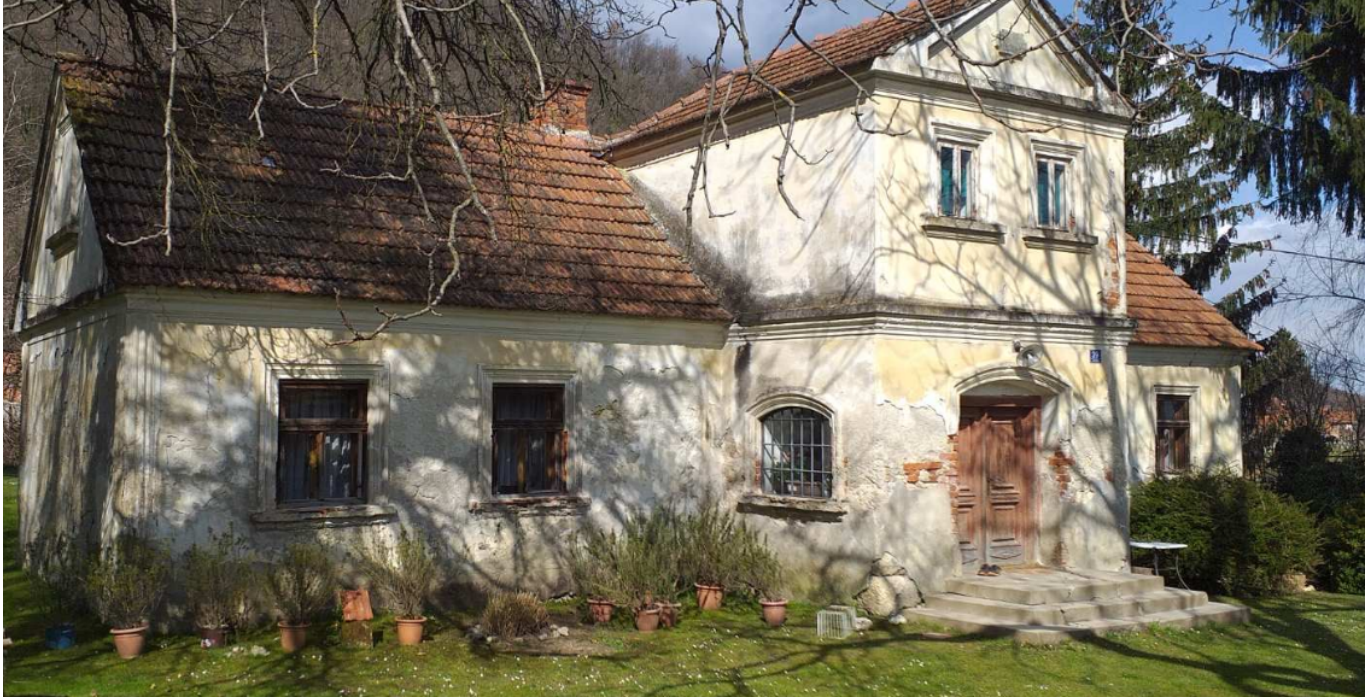
Slika 5.4. Prikaz južnog pročelja
