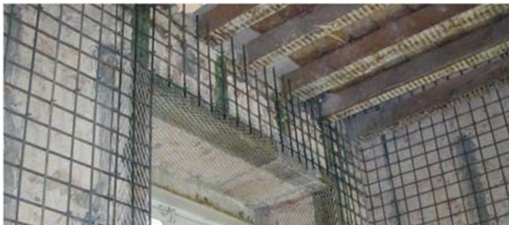
Slika 3.6. Pojačanje armiranim slojem betona
