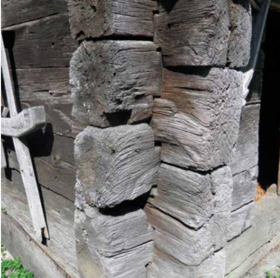
*Slika 2.2. Ugao sa prepustom*
