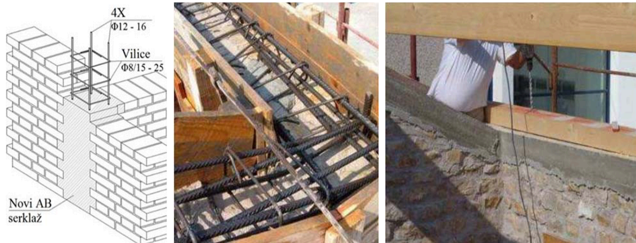
Slika 7.5. Prikaz vertikalnog i horizontalnog serklaža
