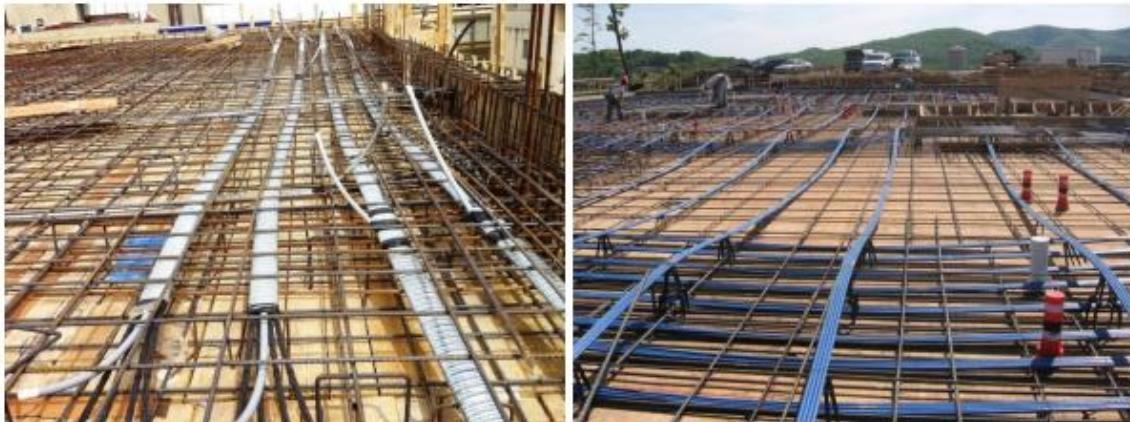
Slika 9: Primjer ploče s „bonded“ i „unbonded“ kabelima
