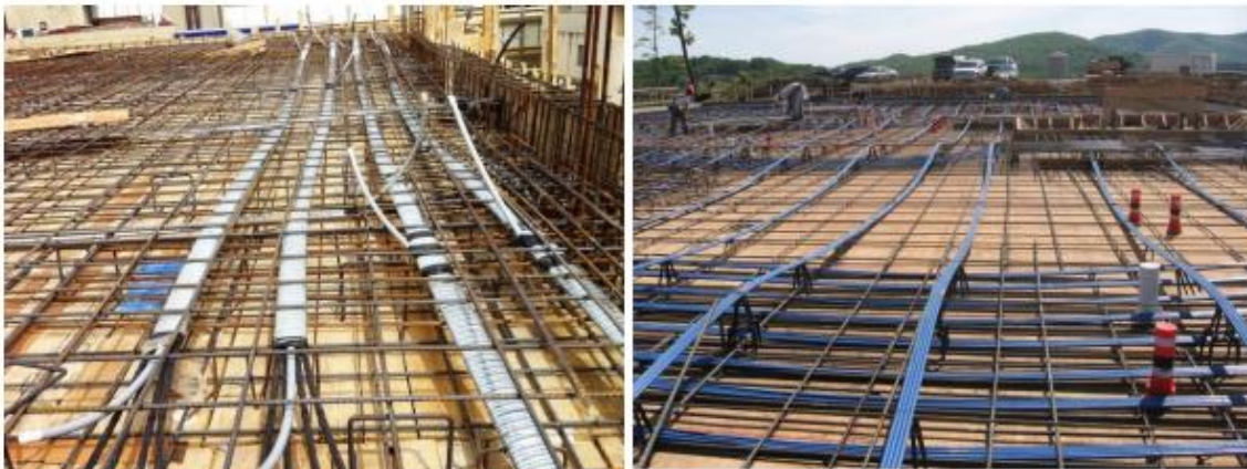
Slika 9: Primjer ploče s „bonded“ i „unbonded“ kabelima
