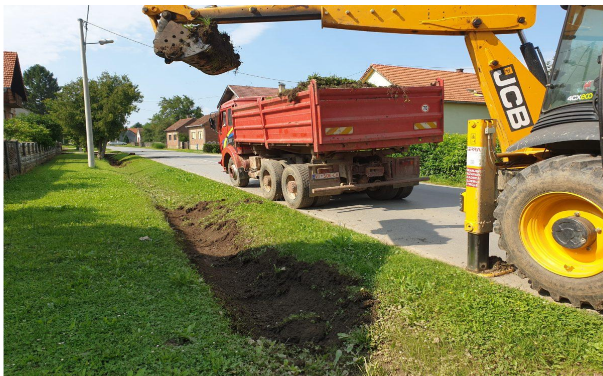
Slika 3. Čišćenje odvodnog jarka Kombinirkom
