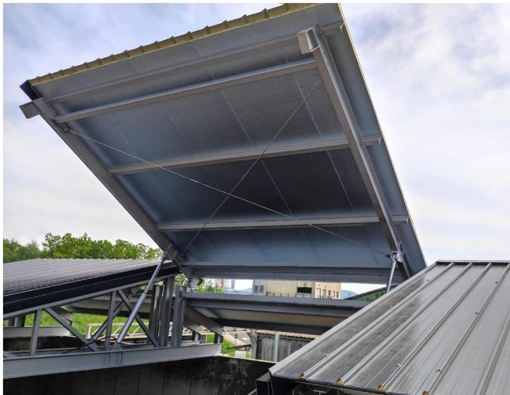
Slika 15: Podizni čelični krov sa sendvič panelima
