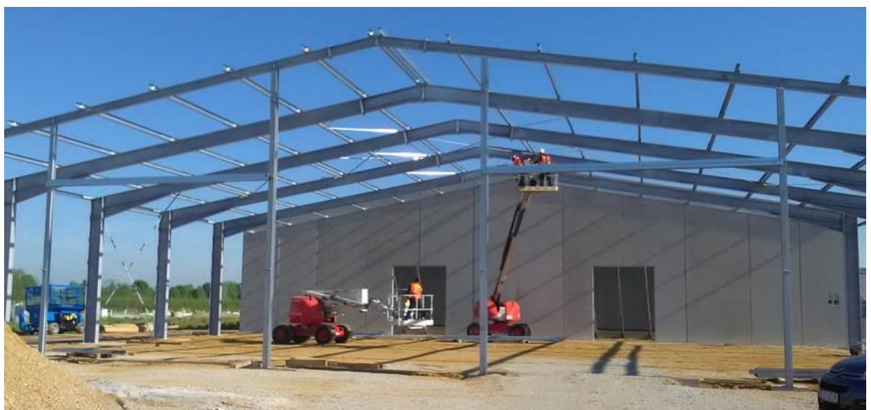
*Slika 16: Čelična konstrukcija hale*
