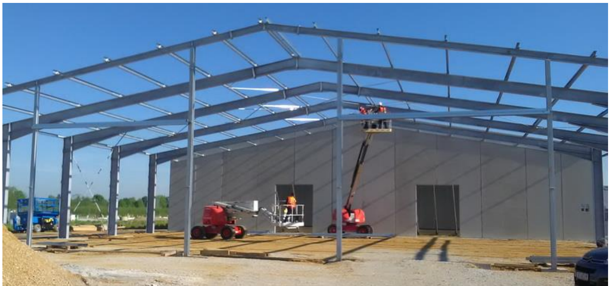
Slika 16: Čelična konstrukcija hale
