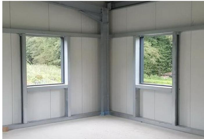
*Slika 17: Nosiva čelična konstrukcija fasade i prozora*
