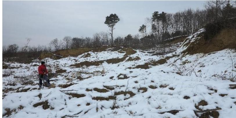
Slika 17: Iskolčenje pozicijskih točaka na osi budućeg nožičnog nasipa, u cilju provedbe kontrolnog dinamičkog sondiranja(LUS-DPL)[1]
