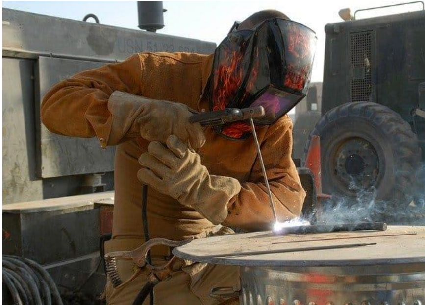
Slika 2. Zavarivanje REL postupkom [5]
