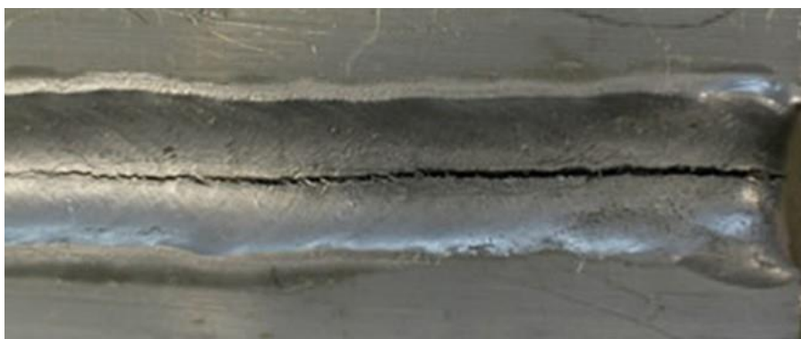
Slika 12. Pukotina u zavarenom spoju [12]
