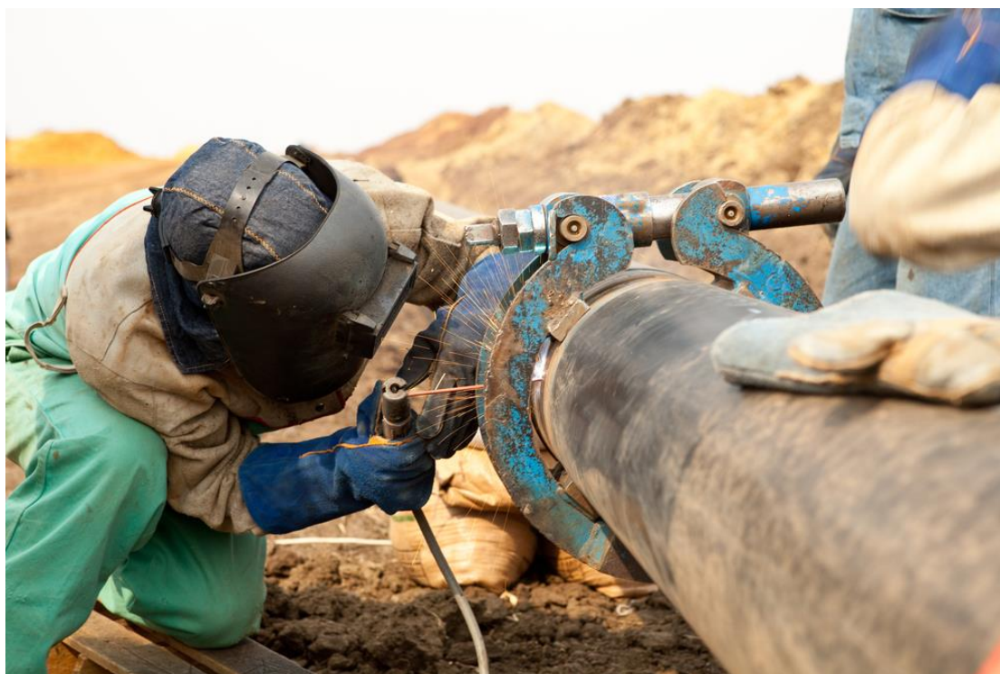
Slika 17. Vanjsko zavarivanje plinovoda [21]
