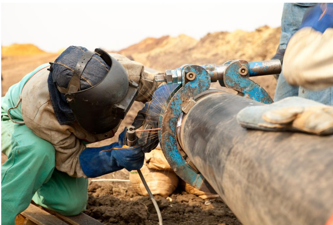
Slika 17. Vanjsko zavarivanje plinovoda [21]
