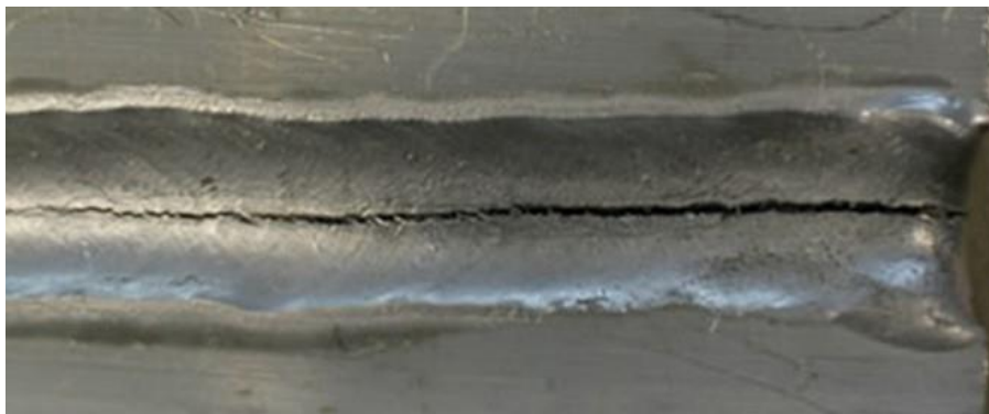
Slika 12. Pukotina u zavarenom spoju [12]
