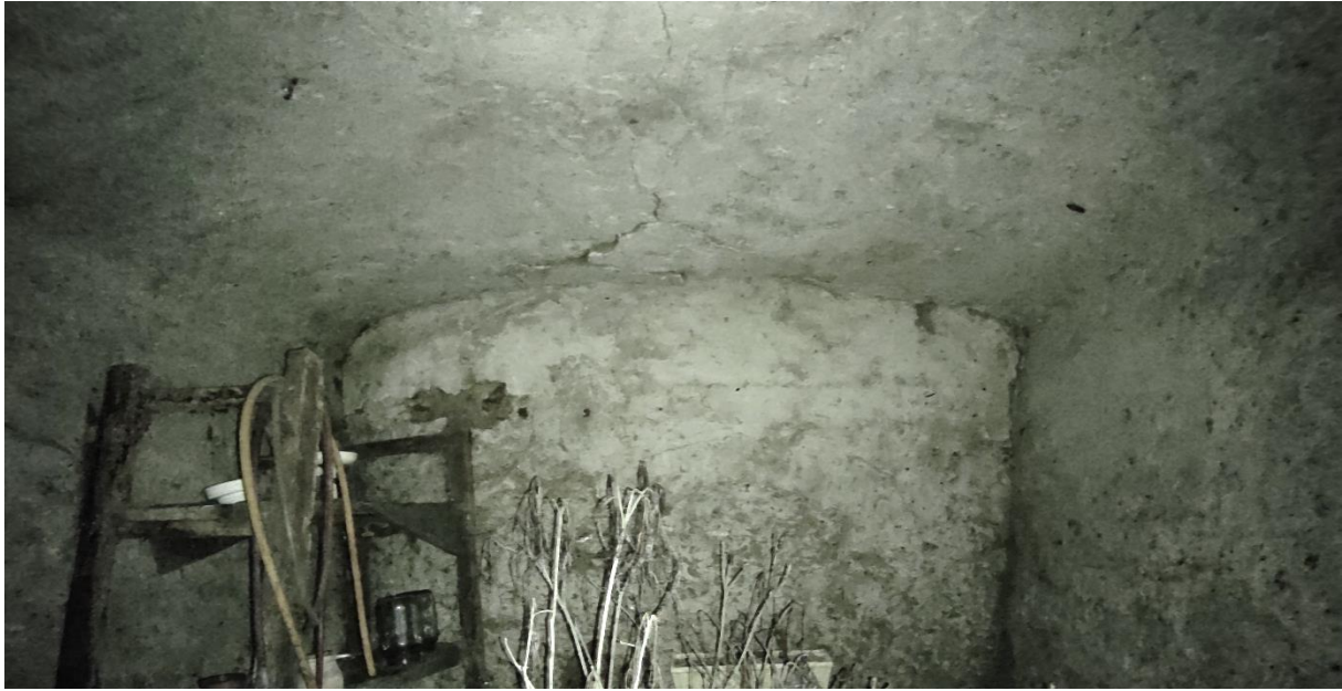
Slika 2.6 - Bačvasti svod podruma
