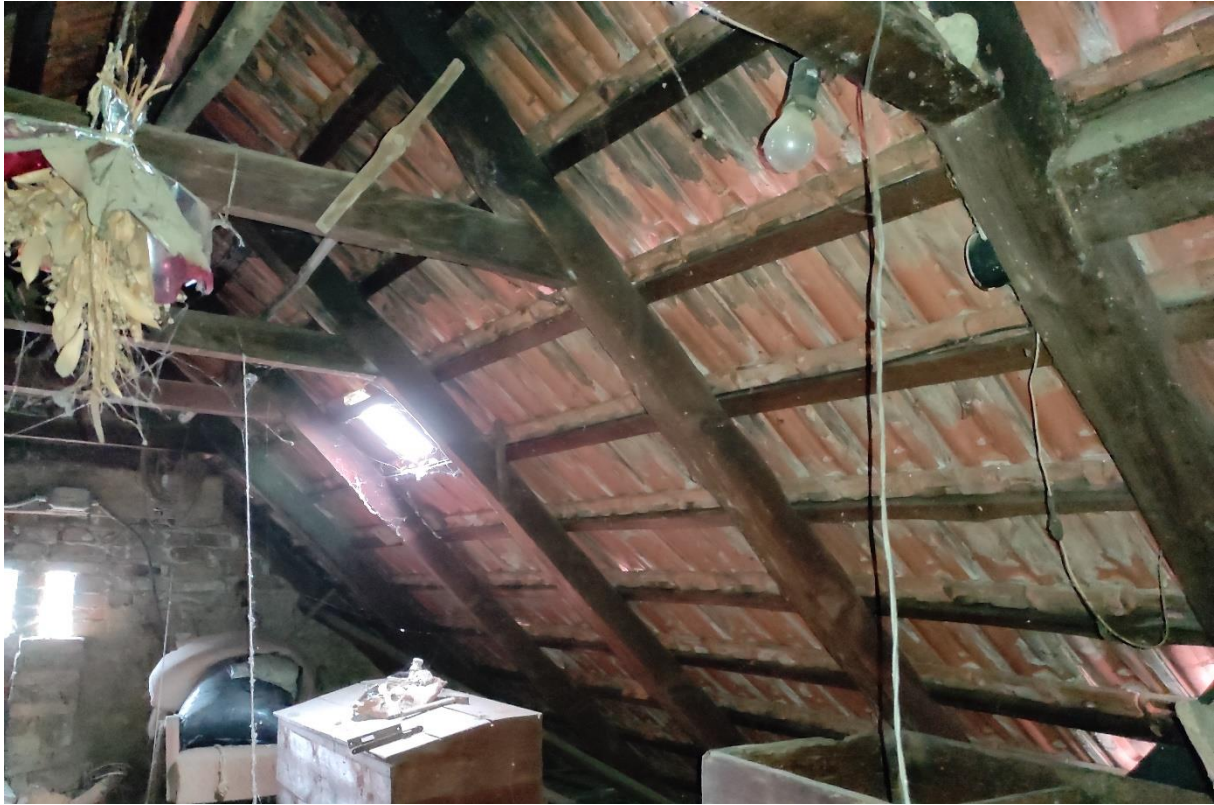
Slika 2.10 - Krovna konstrukcija građevine
