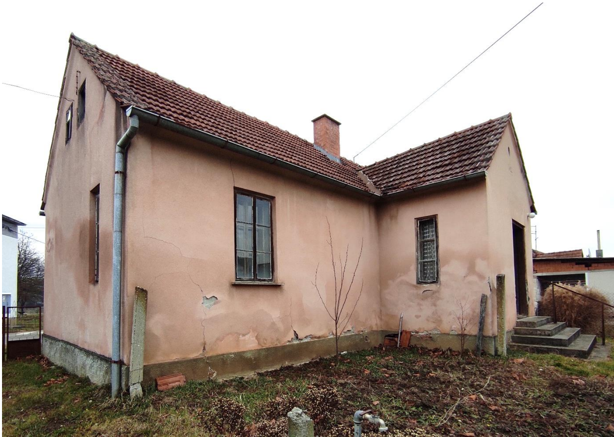
Slika 4.1 - Pogled na južno-zapadno pročelje obiteljske kuće
