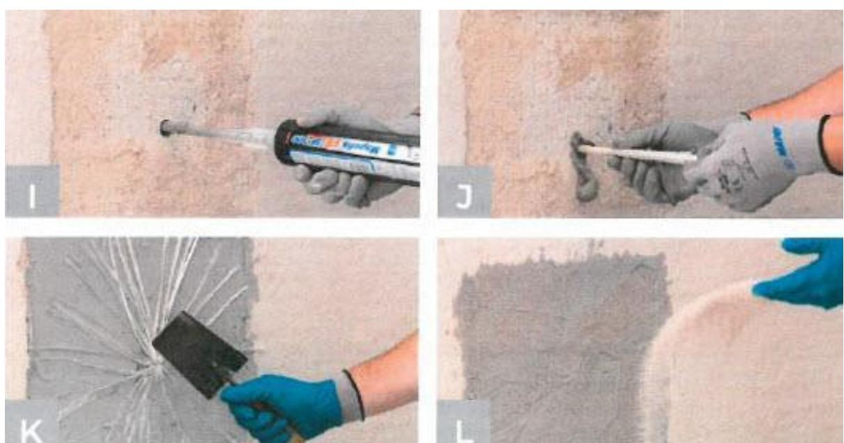
Slika 5.9. Sidrena užad Mapewrap Fiocco- postupak I-L
