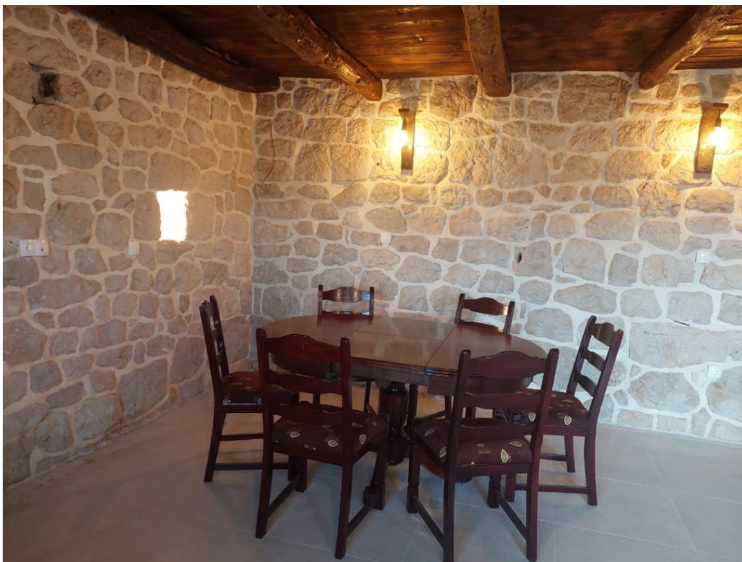
Fotografija 39: Obnovljeni podovi i stropovi u skladu sa preporukama restauratora – Obiteljska kuća Tolić, Grude (Cere) [5]
