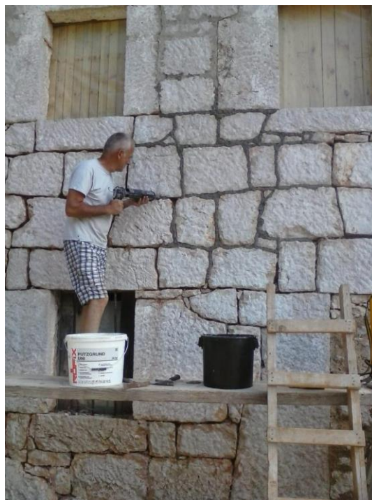
Fotografija 38: Obrada sljubnica – fuga – majstor Jerko Tolić [5]
