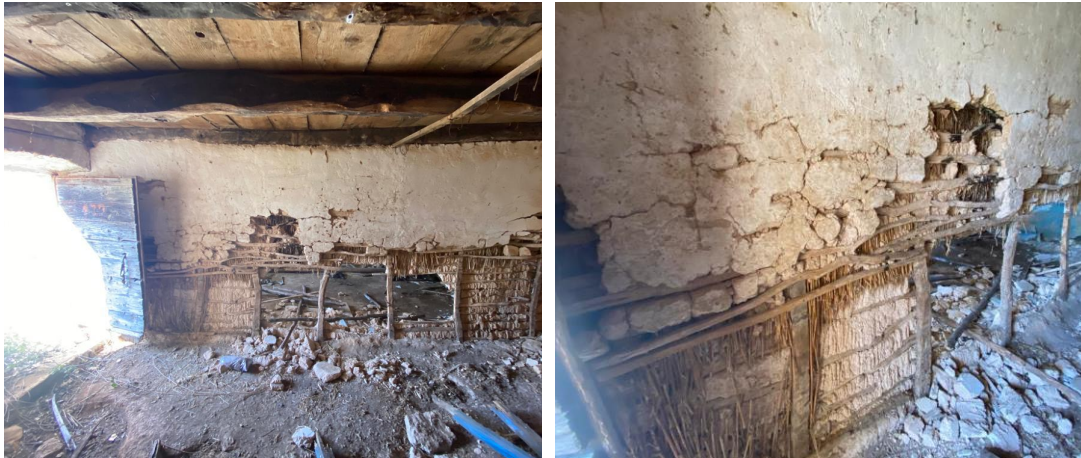
Fotografija 11: Zatečeno stanja – pregradni zid kamene kuće Tolić [3]
