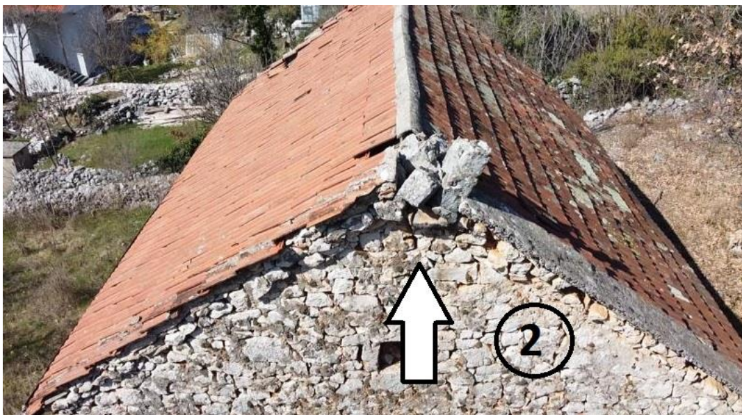
Fotografija 24: Oštećenje zabatnog zida i samog sljemena krovišta (označeno sa br. 1); Oštećenje dimnjaka (označeno sa br. 2); Oštećenje oluka (označeno sa br. 3); Oštećenje crijeva (označeno sa br. 4) [3]
