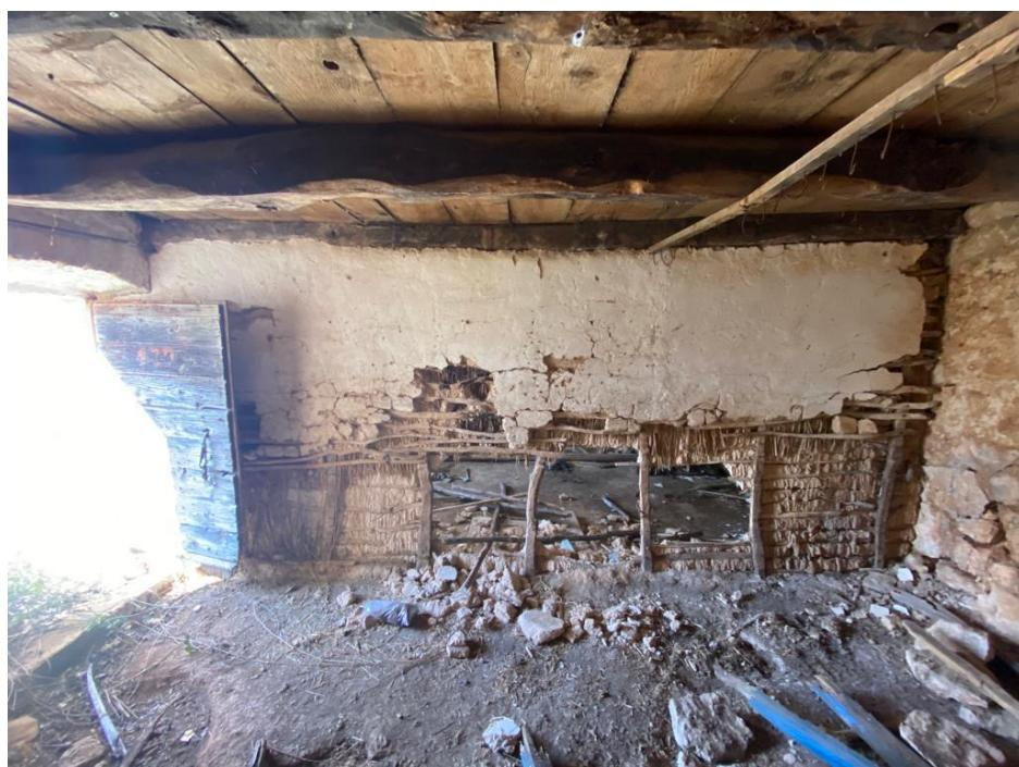
Fotografija 32: Oštećenja na pregradnom zidu [3]
