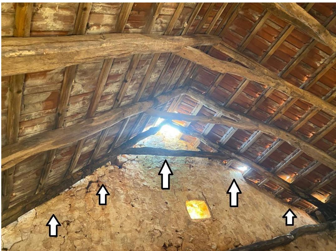
Fotografija 25: Oštećenje zabačnog zida i samog sljemenja krovišta [3]
