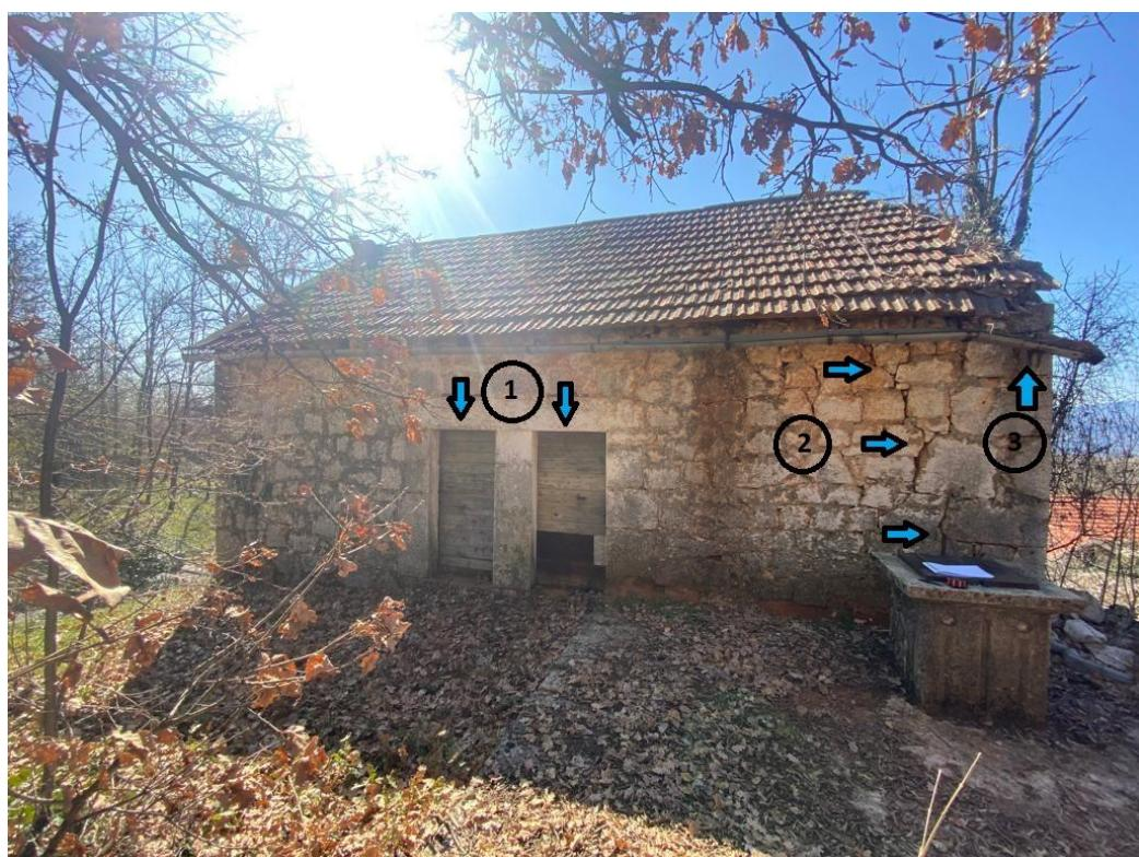
Fotografija 14: Oštećenja vanjskog zida sjeveroistočne strane [3]
