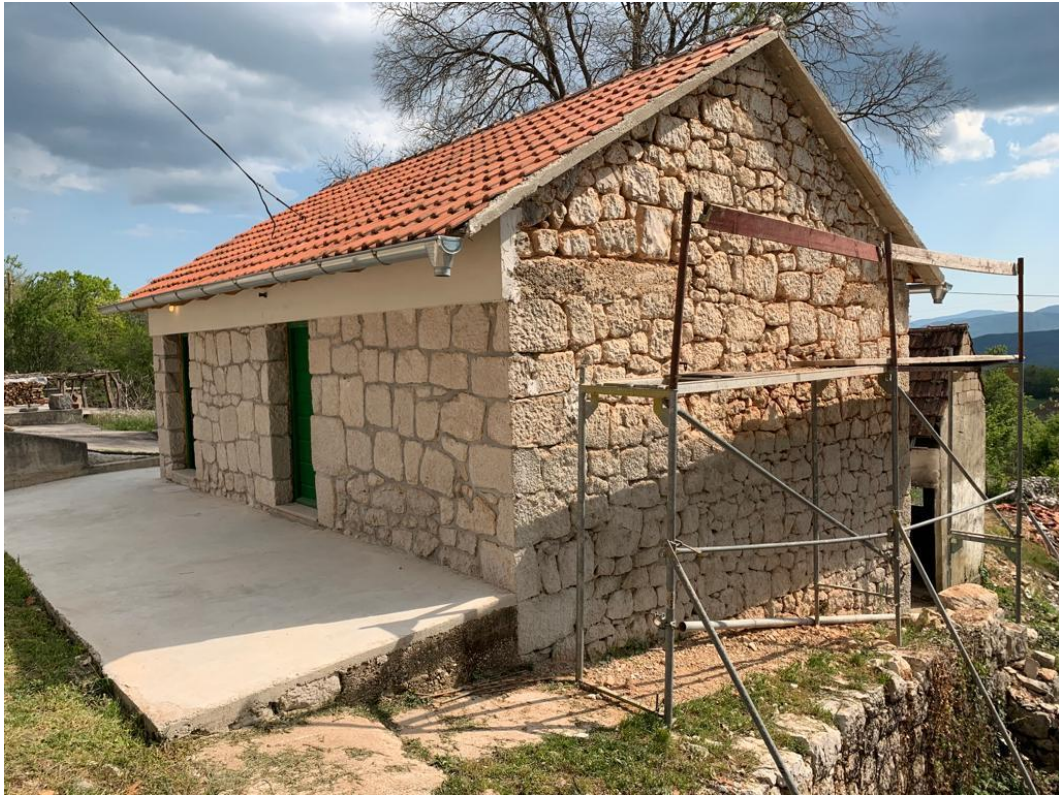
Fotografija 37: Obrada sljubnica –Obiteljska kuća Tolić [5]
