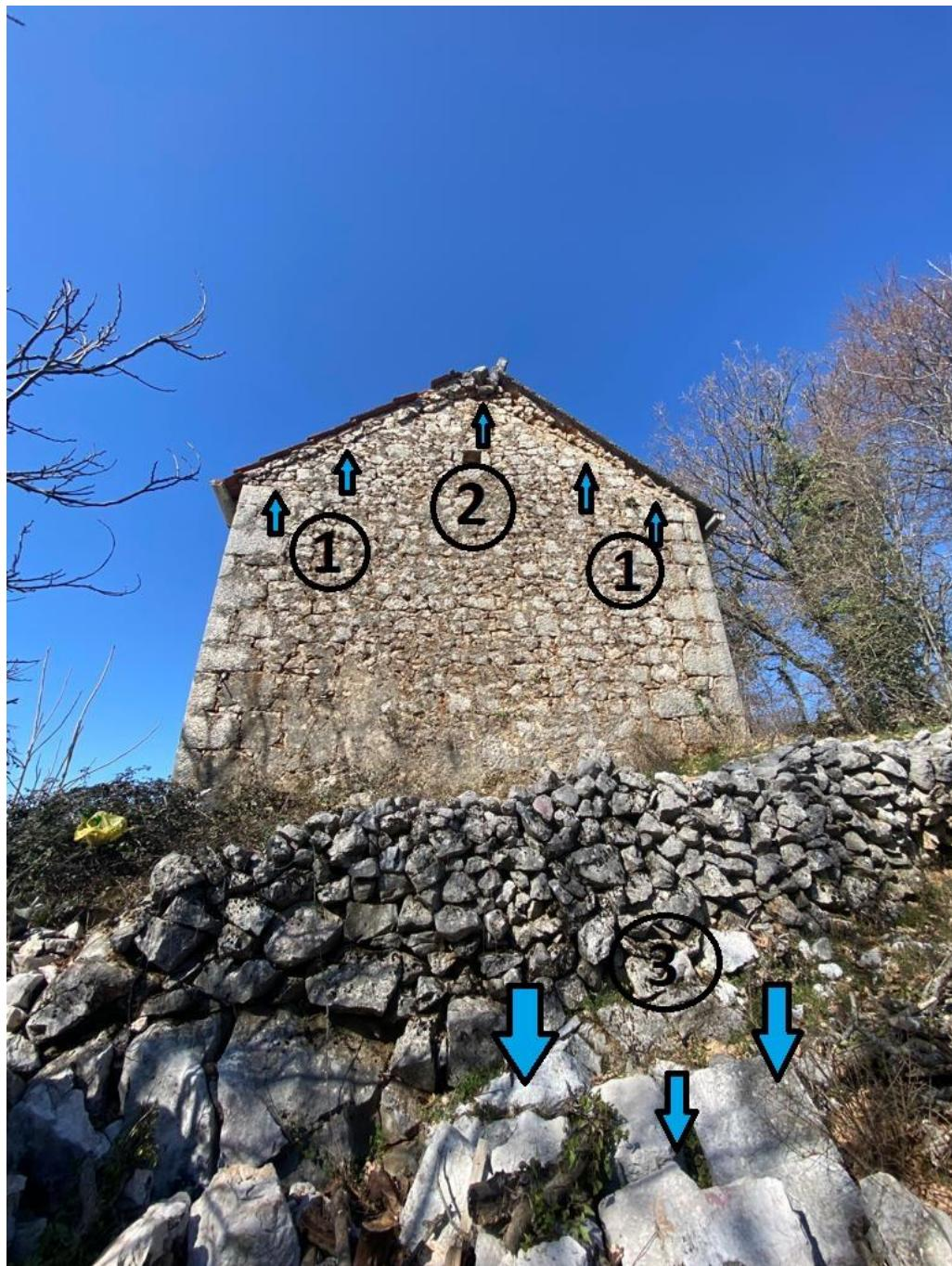
Fotografija 21: Oštećenje zabatnog zida (označeno sa br. 1), Oštećenje – urušavanje dimnjaka (označeno sa br. 2), Ostaci kamenja sa dimnjaka (označeno sa br. 3) [3]
