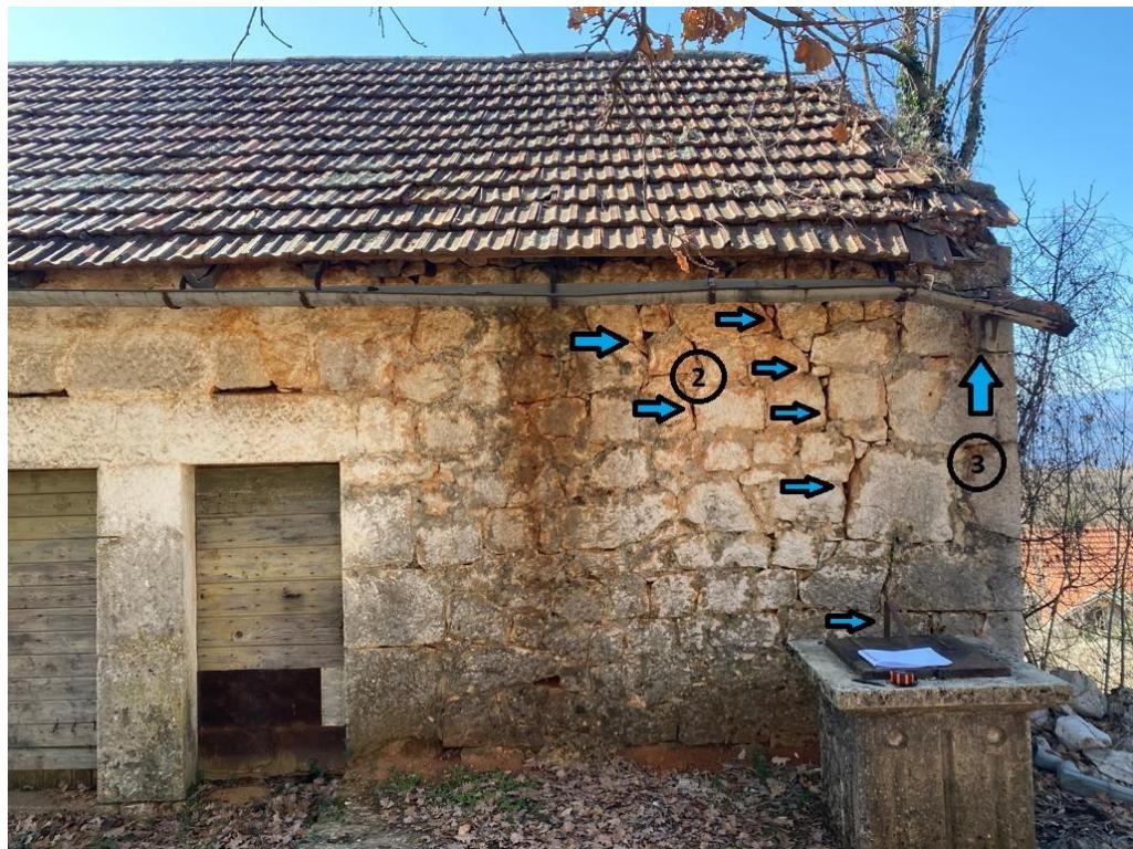
Fotografija 15: Oštećenja vanjskog zida sjeveroistočne strane [3]
