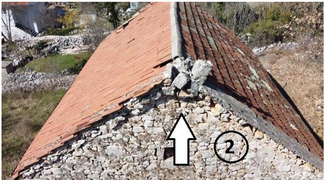
Fotografija 24: Oštećenje zabačnog zida i samog sljemenja krovišta (označeno sa br. 1); Oštećenje dimnjaka (označeno sa br. 2); Oštećenje oluka (označeno sa br. 3); Oštećenje crijeva (označeno sa br. 4) [3]
