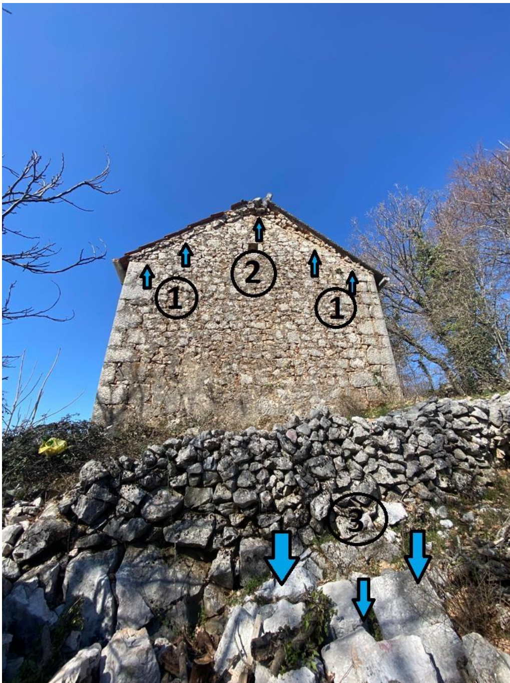
Fotografija 21: Oštećenje zabatnog zida (označeno sa br. 1), Oštećenje – urušavanje dimnjaka (označeno sa br. 2), Ostaci kamena sa dimnjaka (označeno sa br. 3) [3]
