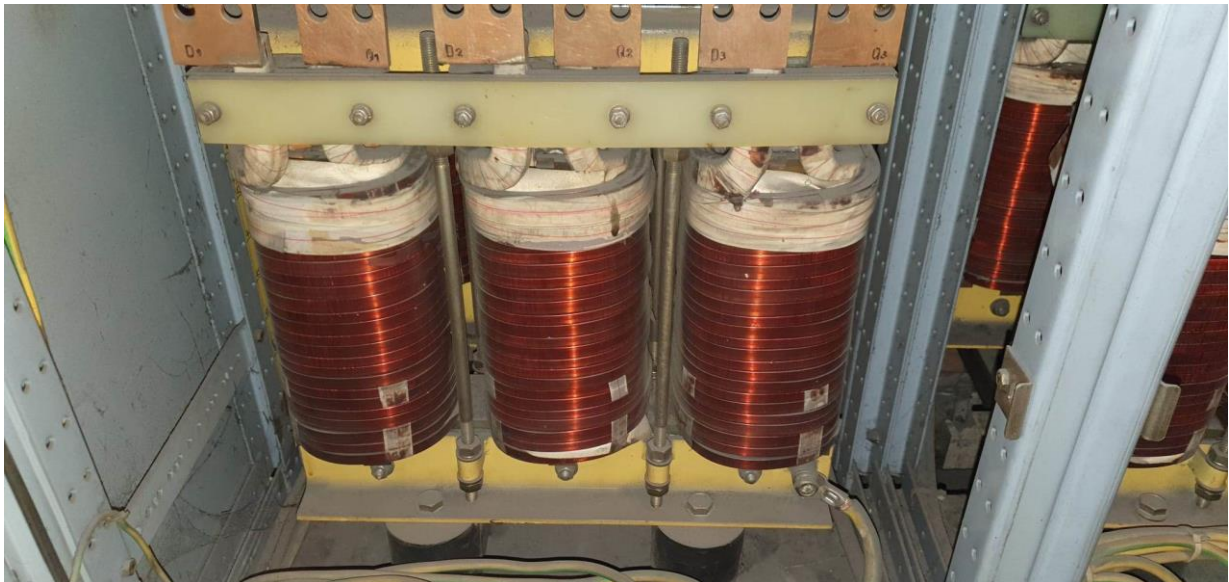
Slika 27. Trofazne kondenzatorske prigušnice
