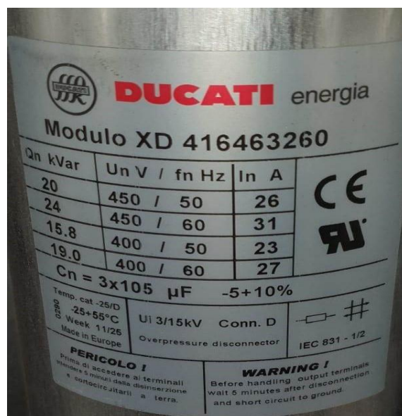
Slika 25. Nazivni podaci kondenzatorske baterije
