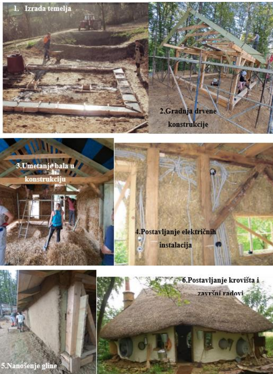
Slika 3.11. Ukratko opisana procedura gradnje kuće od ekoloških materijala
