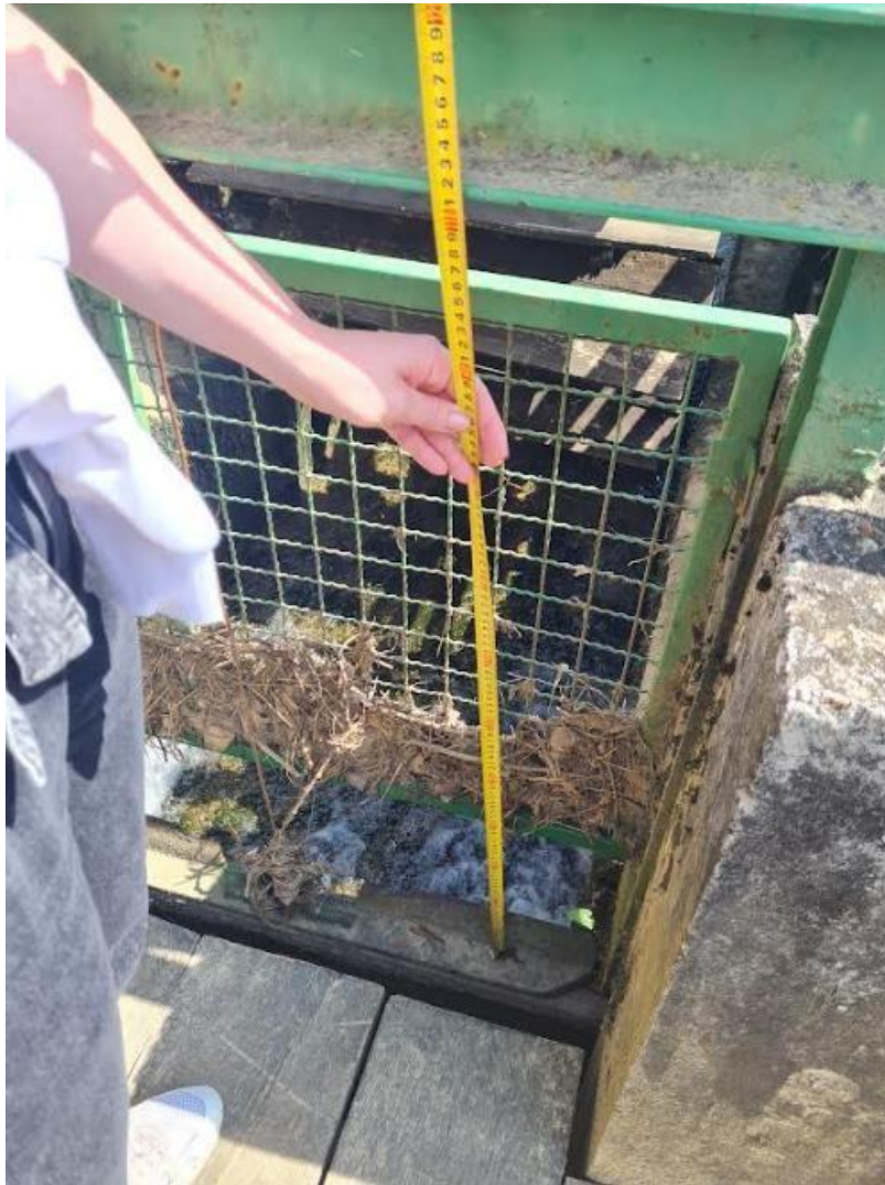
Slika 30. Određivanje visine zapornice i puštanje vode prema vodnom kolu [8]
