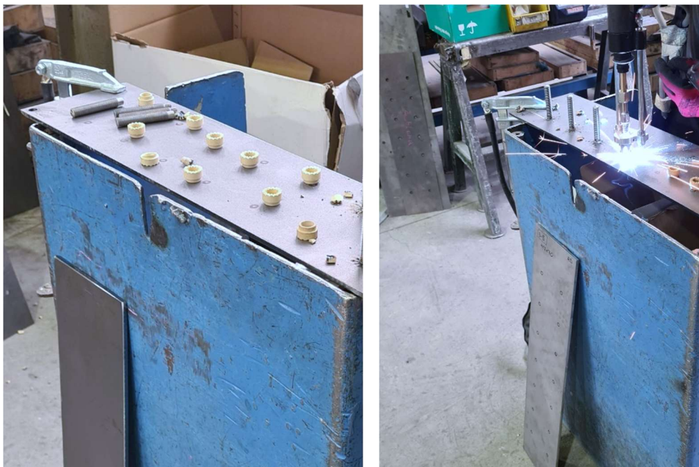
Slika 4.11. Priprema svornjaka i pripadajućih keramičkih prstenova za zavarivanje (lijevo) i tijekom elektrolučnog zavarivanja svornjaka s keramičkim prstenovima (desno)
