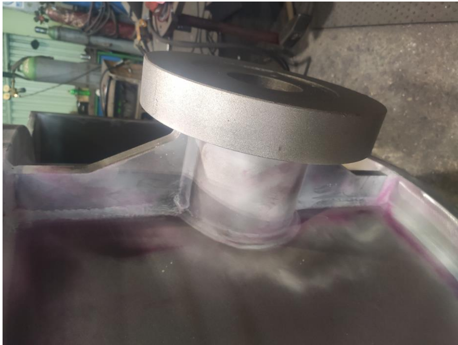
Slika 63 Ispitivanje penetrantom zavarenog spoja ukruta, plašta i nabe
