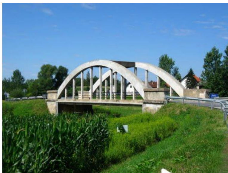
Slika 3.4.1. Vodomjerna stanica Tuhovec [6]
