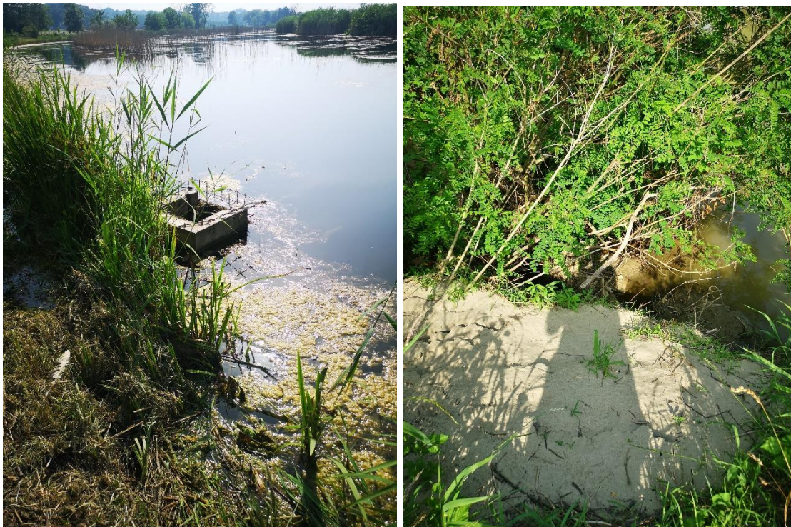
Slika 5.2.14. Propust i cijev za evakuaciju vode u rijeku Bednju (21.06.2023.)[12]
