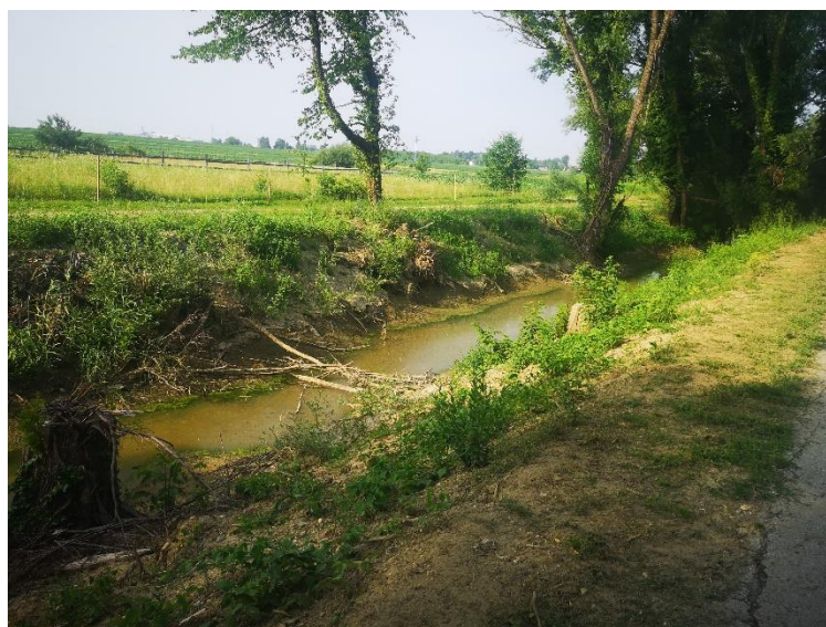
Slika 5.2.8. Početak derivacijskog kanala (21.06.2023.)[12]
