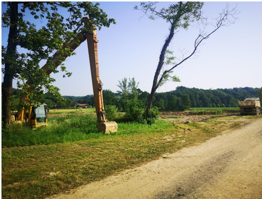
Slika 5.2.6. Građevinska mehanizacija kod rijeke Bednje [12]
