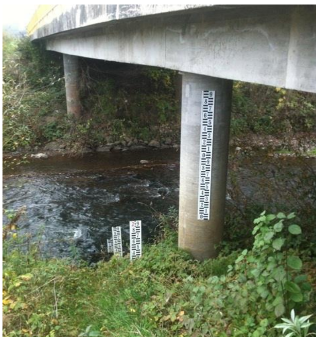
Slika 3.3.1. Vodomjerna stanica Ključ [6]
