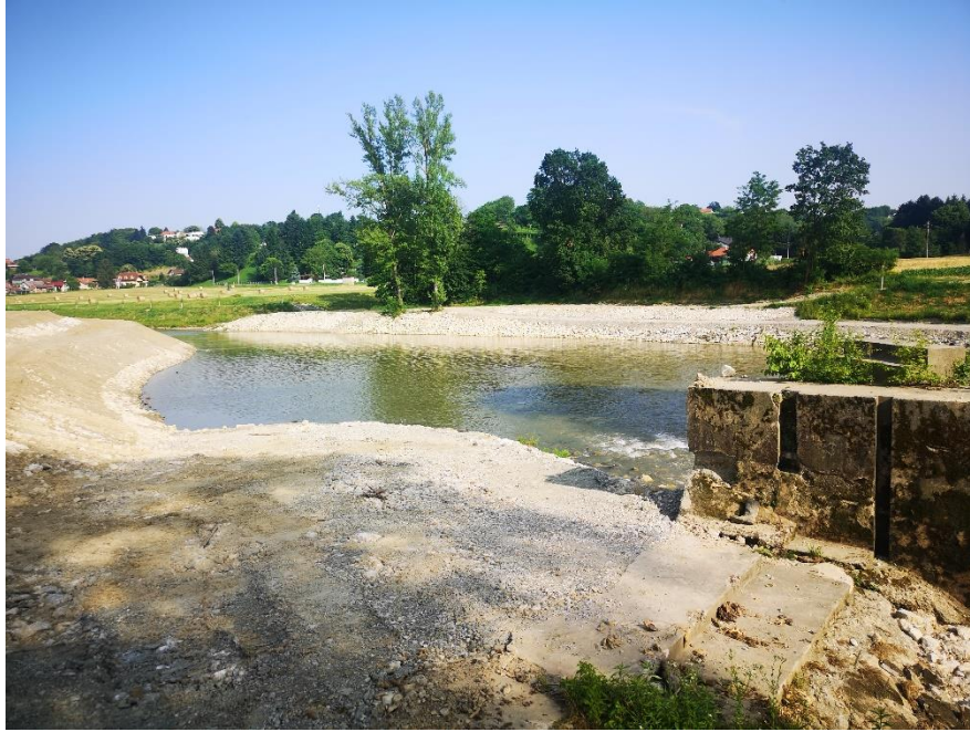
Slika 5.2.5. Obaloutvrda na rijeci Bednji [12]
