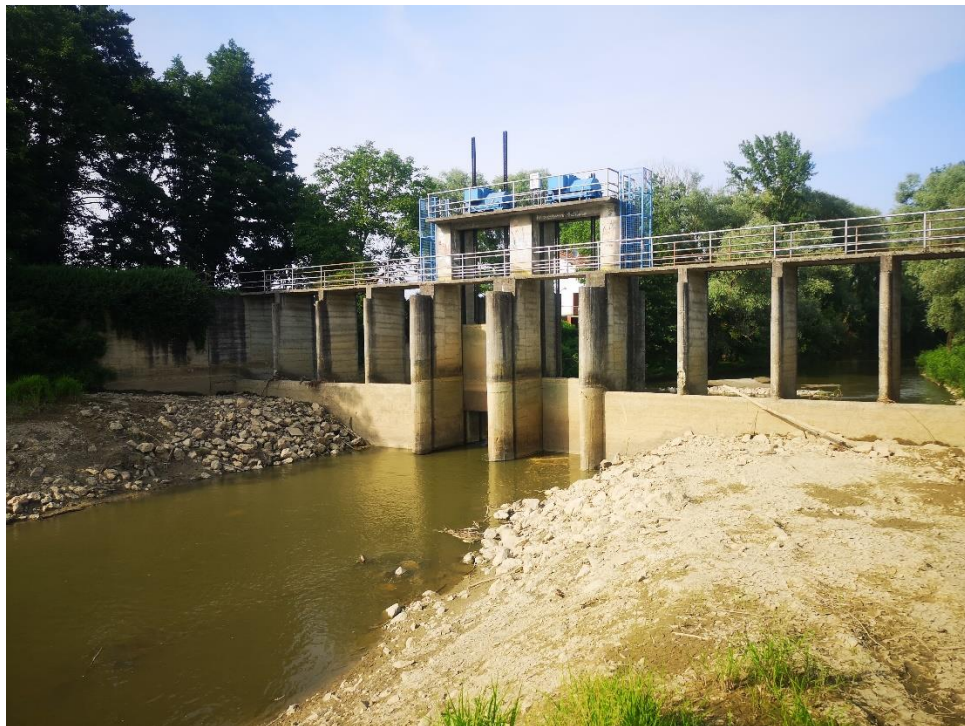
Slika 4.2. Brana u Kućanu Ludbreškom [12]
